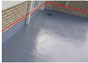
Bendro naudojimo lodžių grindų hidroizoliacija
