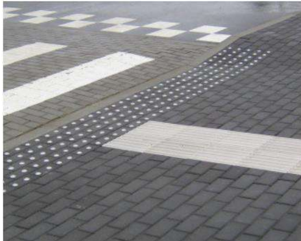
1 pav. Įspėjamųjų paviršių įrengimas prieš laiptų aikšteles
