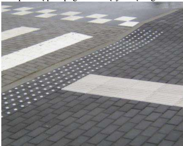
1 pav. Įspėjamųjų paviršių įrengimas prieš laiptų aikšteles
