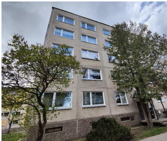
Pav. 5. Pastato rytinio fasado fotofiksacija
