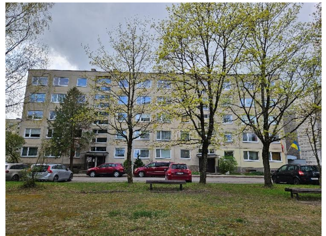
Pav. 6. Pastato rytinio fasado fotofiksacija
