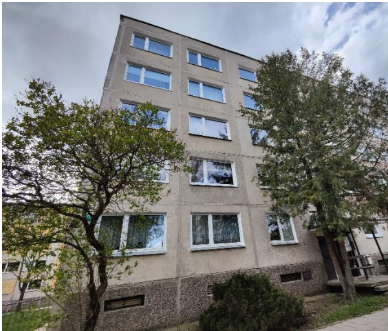
Pav. 4. Pastato rytinio fasado fotofiksacija
