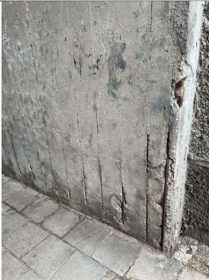
2 pav. Praėjimo sienų atvira armatūra
