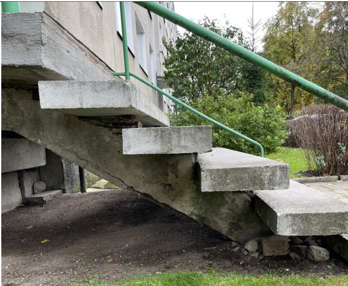
8. pav. Lauko laiptai, atvira laiptasijos armatūra
