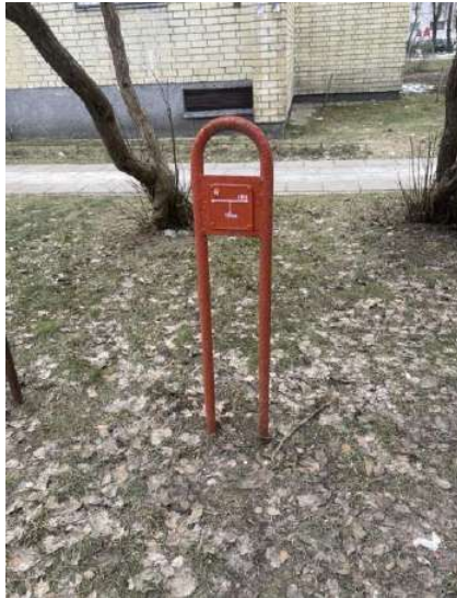
13. Pav. Gaisrinio hidranto, esančio prie namo kieme žymėjimo stovas atnaujintas, gaisrinio hidranto šulinys neužstatomas automobiliais..
