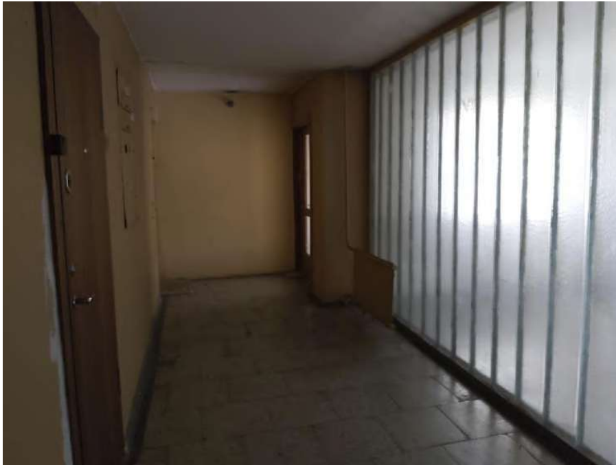
4. Pav. Iš butų aukštuose išeinama į plačius koridorius, kurie veda į N1 tipo laiptinės balkoną iš kurio patenkama į šildomą laiptinę. Liftų holas nuo koridorių atskirtas stiklo blokų sienomis.
