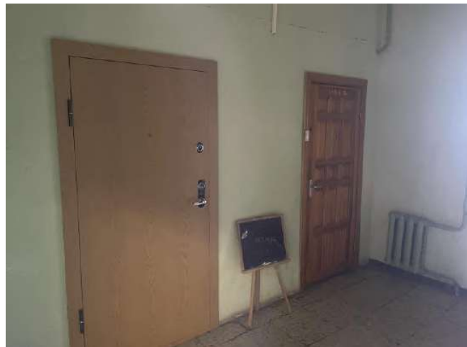
14. Pav. Daug butų turi šarvo tipo duris, tačiau yra ir medinių durų. Prie butų naudojami degių medžiagų kilimėliai. Laiptinėje rūkoma, palikta stiklainiai su nuorūkomis. Gaisro aptikimo ir signalizavimo sistemos nėra.
