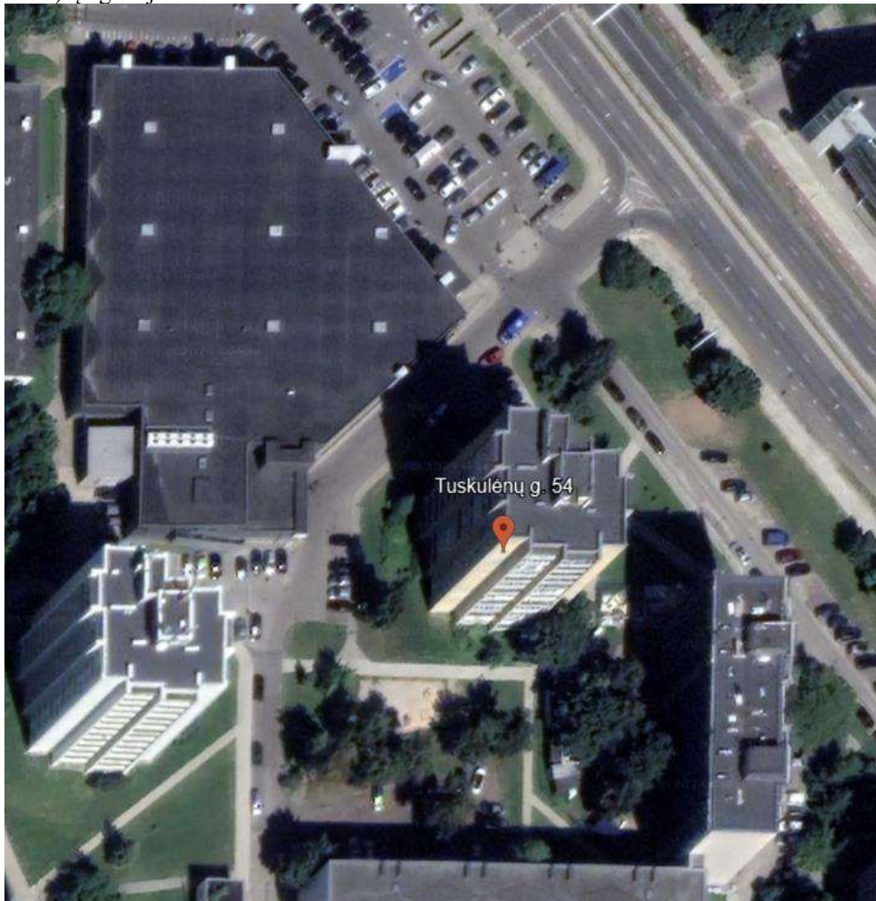
1. Pav. Modernizuojamas 12 aukštų gyvenamasis pastatas Tuskulėnų g. 54, Vilniuje.
