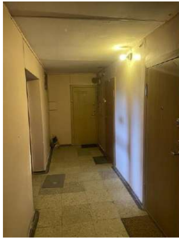
14. Pav. Daug butų turi šarvo tipo duris, tačiau yra ir medinių durų. Prie butų naudojami degių medžiagų kilimėliai. Laiptinėje rūkoma, palikta stiklainiai su nuorūkomis. Gaisro aptikimo ir signalizavimo sistemos nėra.
