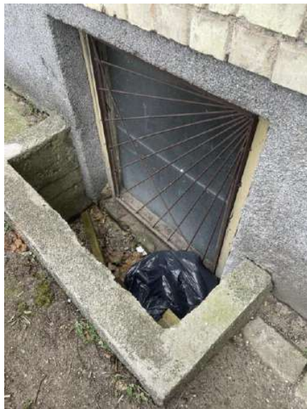
12. Pav. Pastato perimetru yra du dideli langai rūšio aukšte ir keletas mažų tačiau jie nevarstomi, prieduobės netvarkingos
