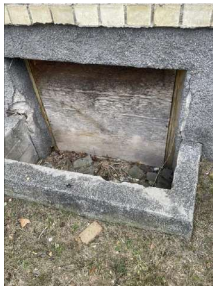
12. Pav. Pastato perimetru yra du dideli langai rūšio aukšte ir keletas mažų tačiau jie nevarstomi, prieduobės netvarkingos
