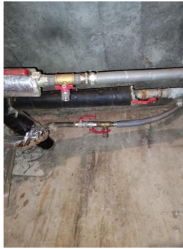
14. Karštas, cirkuliacinis, šaltas vandentiekis magistraliniai vamzdynai ir uždarojoji armatūra
