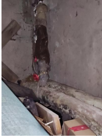
14. Karštas, cirkuliacinis, šaltas vandentiekis magistraliniai vamzdynai ir uždarojoji armatūra
