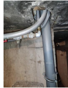
14. Karštas, cirkuliacinis, šaltas vandentiekis magistraliniai vamzdynai ir uždarojoji armatūra
