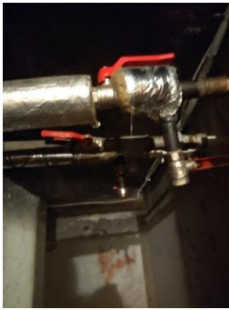
14. Karštas, cirkuliacinis, šaltas vandentiekis magistraliniai vamzdynai ir uždarojoji armatūra
