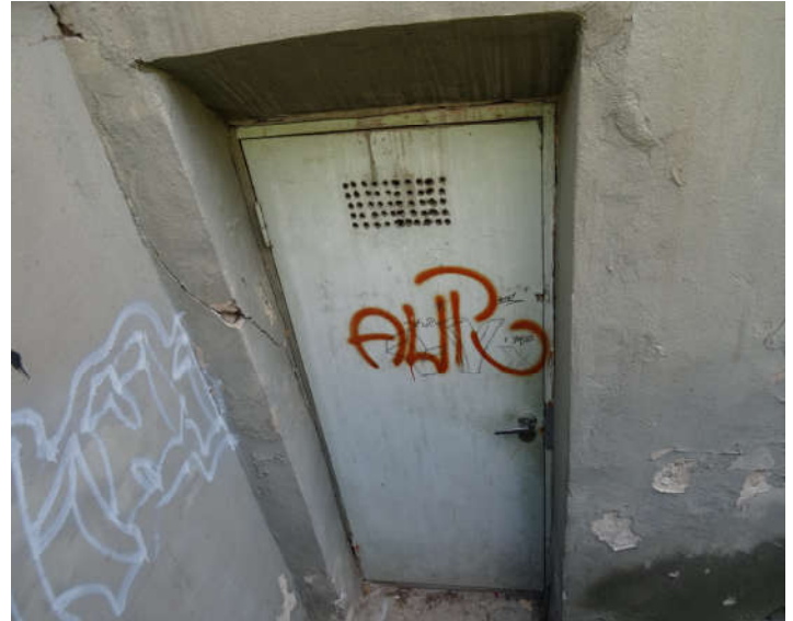
10 ir 11 pav. Bendras pastato išorinių medinių durų vaizdas. Durys susidėvėjusios, nesandarios, sunkiai varstomos, blogai užsidaro, durų šilumos perdavimo charakteristikos neatitinka STR 2.01.02:2016 „Pastatų energinio naudingumo projektavimas ir sertifikavimas“ reikalavimų.
