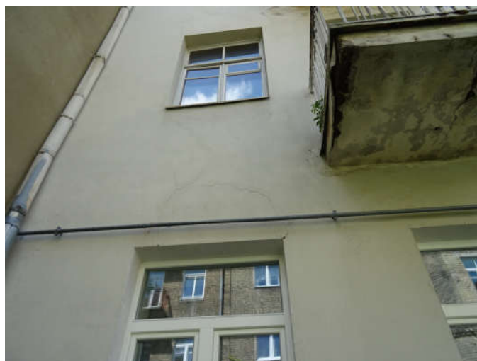
1, 2, 3 ir 4 pav. Bendras pastato fasadų vaizdas. Vietomis stebimi fasadų apdailos pažeidimai – nusilupę dažai, tinko nutrupėjimai, nedidelio pločio plyšiai tinke.
