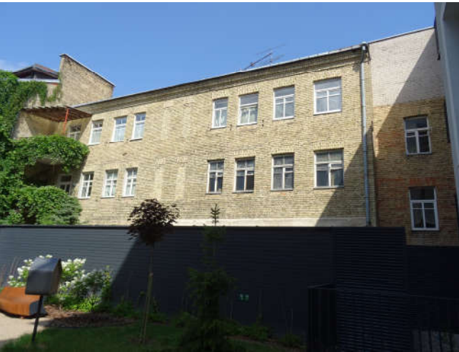
12 ir 13 pav. Kiemo pusės pastato fasado bendras vaizdas. Fasadas netinkuotas; vietomis stebimi apdailinio plytų mūro pažeidimai (nuskilusios plytos), plytų mūro siūlių ištrupėjimai.
