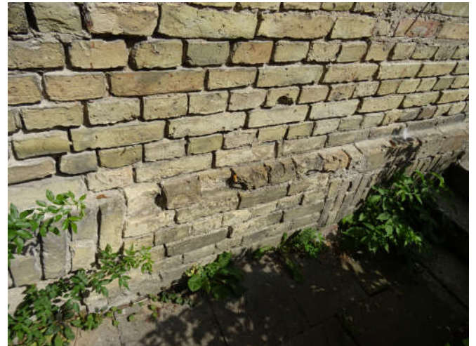
12 ir 13 pav. Kiemo pusės pastato fasado bendras vaizdas. Fasadas netinkuotas; vietomis stebimi apdailinio plytų mūro pažeidimai (nuskilusios plytos), plytų mūro siūlių ištrupėjimai.
