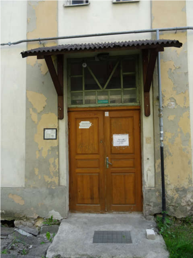
10 ir 11 pav. Bendras pastato išorinių medinių durų vaizdas. Durys susidėvėjusios, nesandarios, sunkiai varstomos, blogai užsidaro, durų šilumos perdavimo charakteristikos neatitinka STR 2.01.02:2016 „Pastatų energinio naudingumo projektavimas ir sertifikavimas“ reikalavimų.
