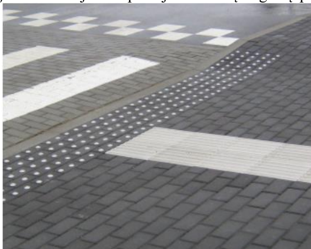
1 pav. Įspėjamųjų paviršių įrengimas prieš laiptų aikšteles ir prieš pandusą ir pakilus pandusu.
