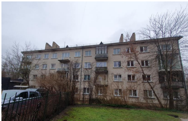
Pav. 2. Pastato Rytinio fasado fotofiksacija
