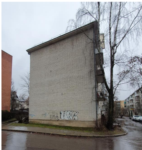
Pav. 1. Pastato Šiaurini fasado fotofiksacija
