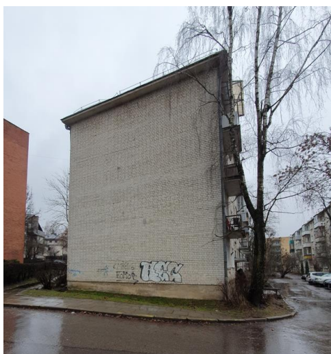
Pav. 3. Pastato Šiaurini fasado fotofiksacija
