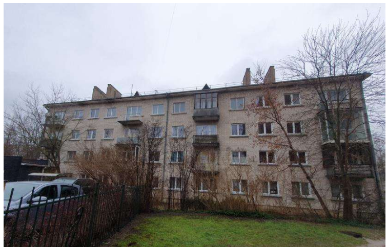
Pav. 4. Pastato Rytinio fasado fotofiksacija
