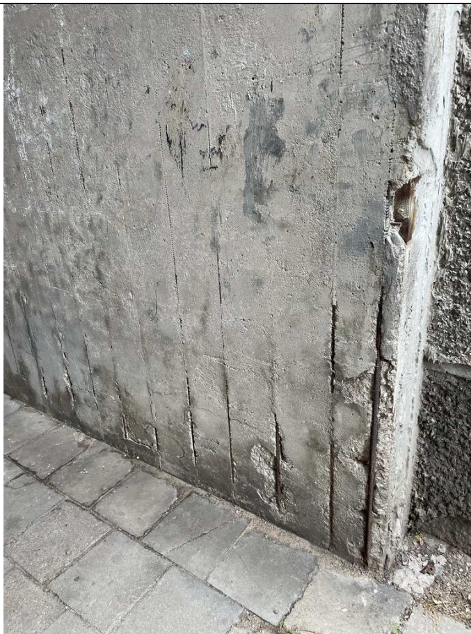
2 pav. Praėjimo sienų atvira armatūra
