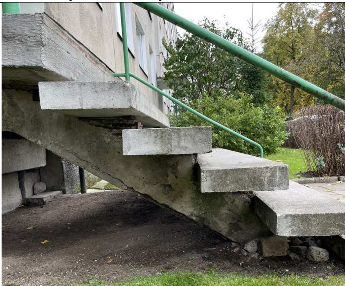
8. pav. Lauko laiptai, atvira laiptasijos armatūra
