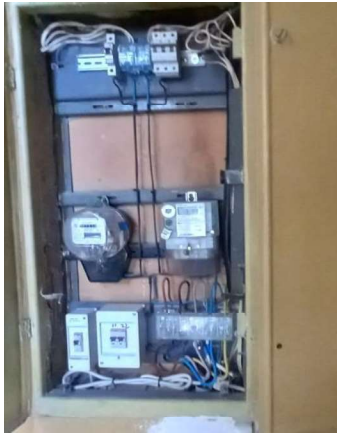
9 pav. Netvarkinga elektros instaliacija – butų elektros apskaitos skyduose laidai neuždengti, neapsaugoti nuo pažeidimų, prisilietimų.
