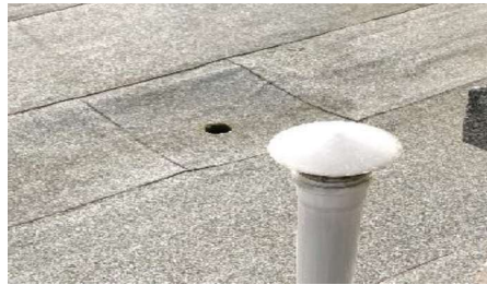
8 pav. Įlajos be šiukšlių gaudyklių.
