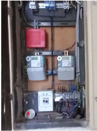
9 pav. Netvarkinga elektros instaliacija – butų elektros apskaitos skyduose laidai neuždengti, neapsaugoti nuo pažeidimų, prisilietimų.
