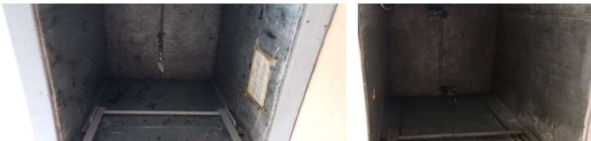
1 pav. Stogo liukai sunkių konstrukcijų, be fiksavimo mechanizmų.
