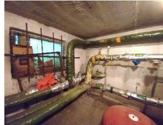
2 pav. Nusidėvėjusios vidaus inžinerinės sistemos – pasenusi, pažeista vamzdynų izoliacija.
