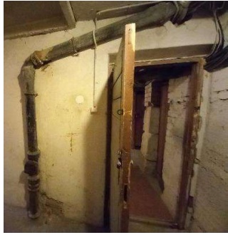
1 pav. Nusidėvėjusios vidaus inžinerinės sistemos. Ant įlajų nėra šiukšlių gaudyklių.
