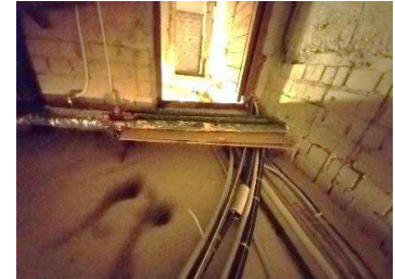
2 pav. Nusidėvėjusios vidaus inžinerinės sistemos – pasenusi, pažeista vamzdynų izoliacija.
