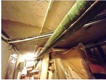
2 pav. Nusidėvėjusios vidaus inžinerinės sistemos – pasenusi, pažeista vamzdynų izoliacija.
