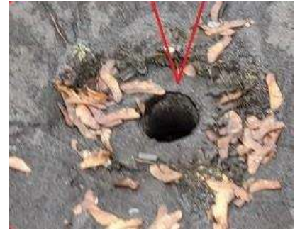
1 pav. Nusidėvėjusios vidaus inžinerinės sistemos. Ant įlajų nėra šiukšlių gaudyklių.
