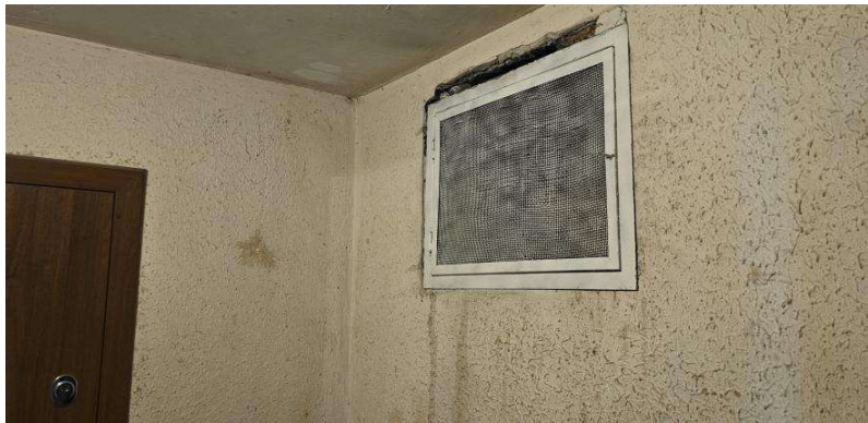
7. Pav. Aukštų koridoriuose yra neveikiančio vidaus gaisrinio vandentiekio gaisrinių čiaupų spintelės, mechaninio dūmų šalinimo vožtuvai neveiks ir ištrupėję sienos prie jų.
