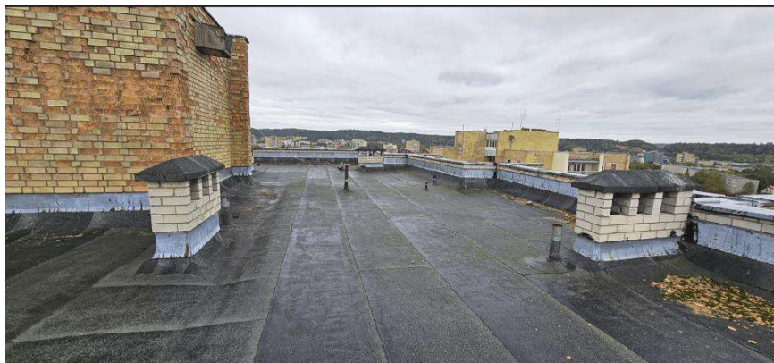
5. Pav. Trupa viršutiniuose aukštuose fasadinės geltonų molio plytų sienos gadinama stogo danga.
