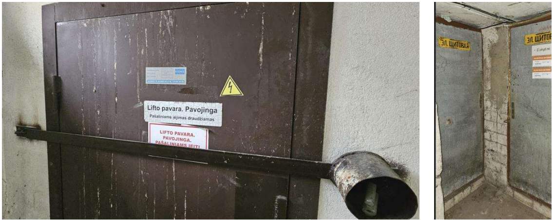
10. Pav. techninės patalpos apsaugotos metalinėmis arba apskardintomis durimis. Numatoma jas pakeisti į priešgaisrines, atitinkančias šiai dienai keliamus reikalavimus.
