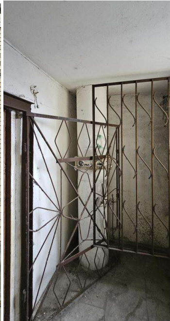
8. Pav. Nors namas stebimas vaizdo stebėjimo kameromis, tačiau saugomasi ir grotomis užtveriant ir evakuacinę laiptinę, reikia visas grotas naikinti.
