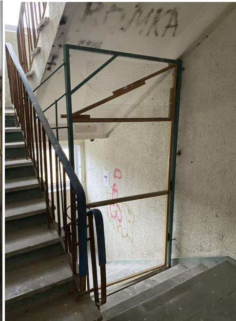
8. Pav. Nors namas stebimas vaizdo stebėjimo kameromis, tačiau saugomasi ir grotomis užtveriant ir evakuacinę laiptinę, reikia visas grotas naikinti.
