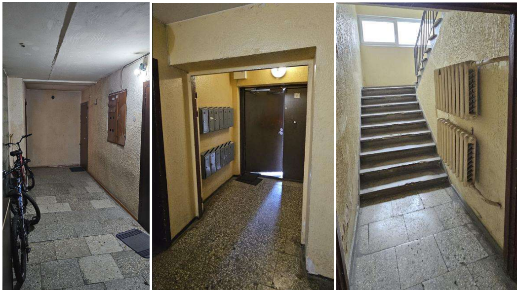
13. Pav. Koridoriuose įrengtos el. apskaitos spintos, apšvietimas šviečia nuo judesio. Durys butų dauguma šarvo tipo. Patekimui į pastatą plačios dvivėrės durys, beveik koridoriaus pločio. N1 tip laiptinėje laiptai 1,3 m pločio. Radijatoriai laiptinėje prakiurę. Gaisro aptikimo ir signalizavimo sistemos nėra.
