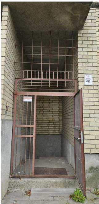
8. Pav. Nors namas stebimas vaizdo stebėjimo kameromis, tačiau saugomasi ir grotomis užtveriant ir evakuacinę laiptinę, reikia visas grotas naikinti.
