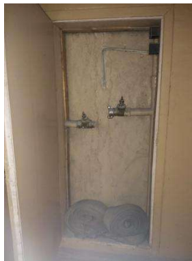
7. Pav. Aukštų koridoriuose yra neveikiančio vidaus gaisrinio vandentiekio gaisrinių čiaupų spintelės, mechaninio dūmų šalinimo vožtuvai neveiks ir ištrupėję sienos prie jų.
