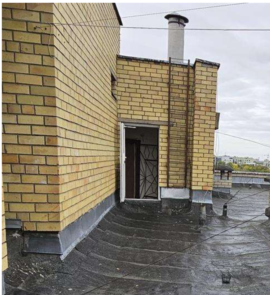
5. Pav. Trupa viršutiniuose aukštuose fasadinės geltonų molio plytų sienos gadinama stogo danga.
