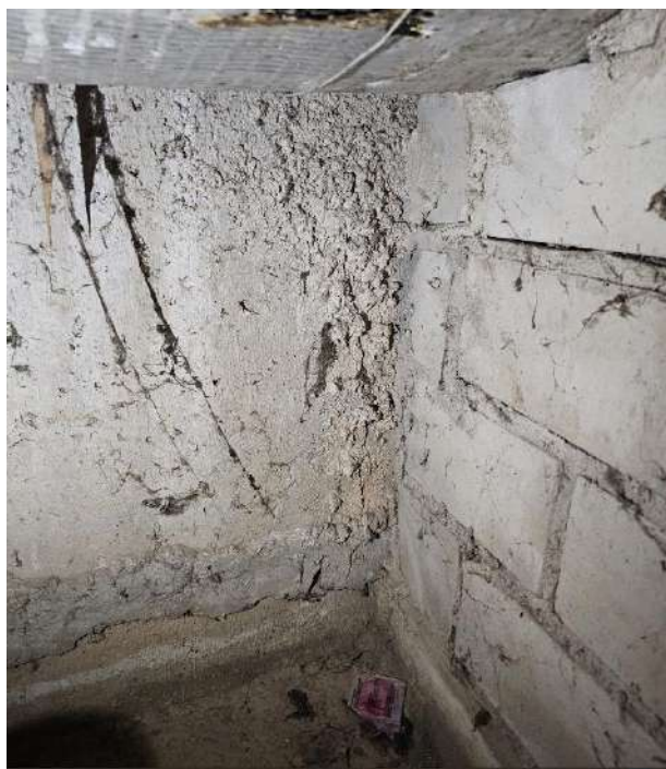
10 pav. Pamato vidinė pusė - stebima patvanka.
