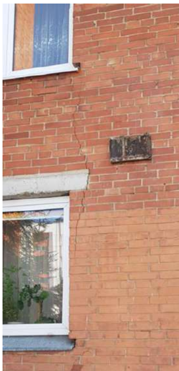
21 pav. Matomi trūkiai sienų angokraščiuose
