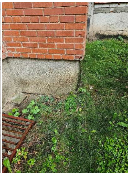
11 pav. Pamatas išorėje drėksta.
