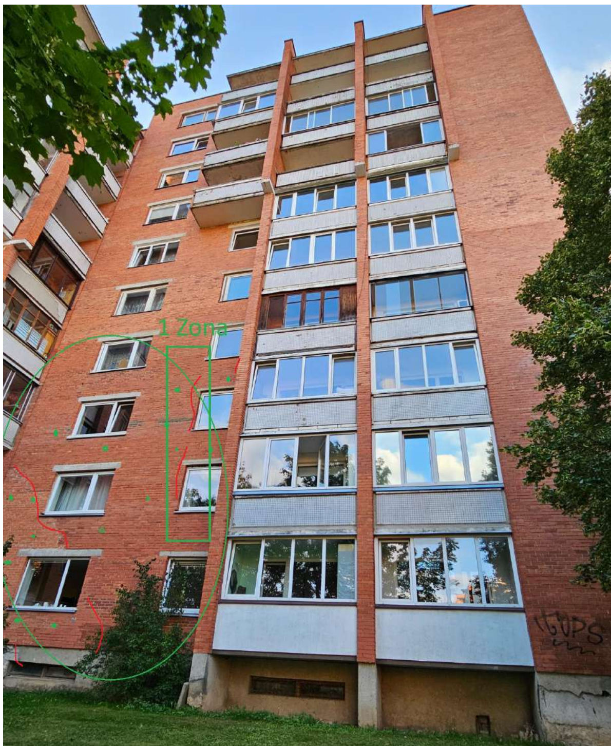
17. pav. Pastato Nr.26 rytinis fasadas, pastato sienos ašyje C-C deformacijos pažymėtos raudonai, remontinės tvirtinimo smeigės – žaliai, suremontuotas sienos plotas žaliais taškais ir apskritimu, žalias kvadratas – angokraščių stiprinimo 1 zona .
