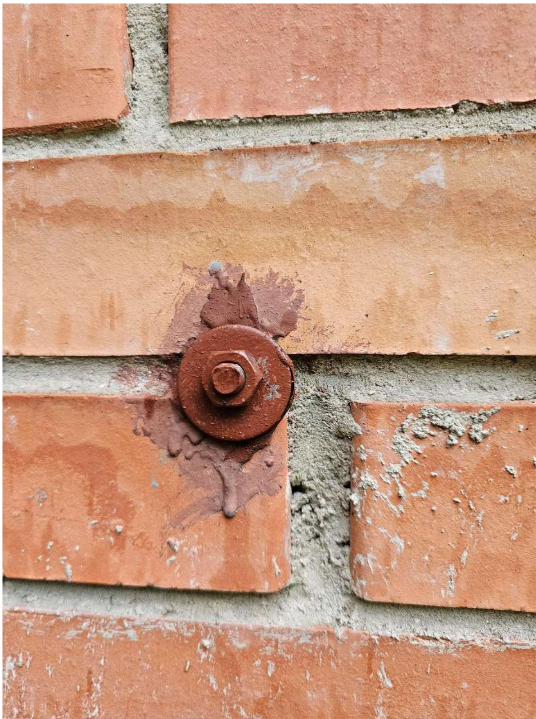
39 pav. Remontinio ankerio fragmentas pastate Nr. 26 rytinė siena ašyje C-C.
