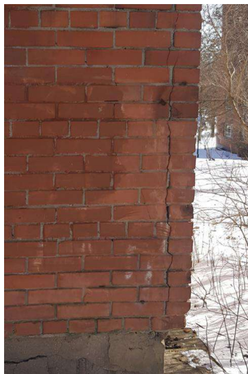
22 pav. Ašis A-A, atitrūkęs išorinis sluoksnis.
