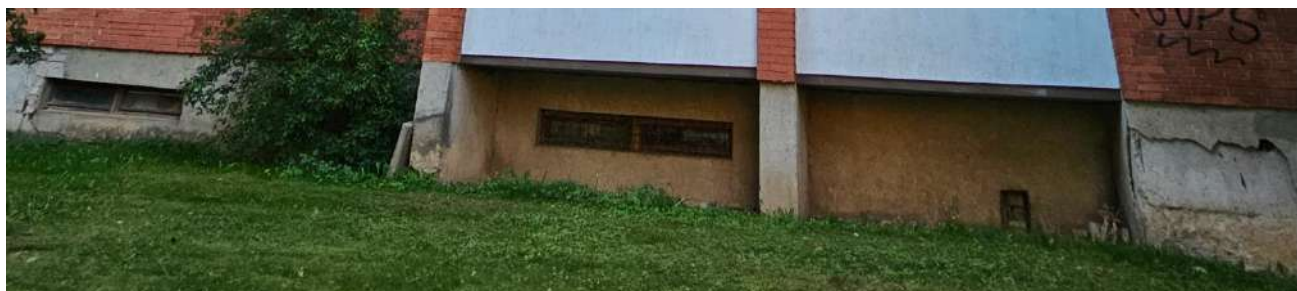
8 pav. Pastato Nr. 26 pamatai ašyje C-C neturi apdailinio sluoksnio ar /ir jis nukritęs.
