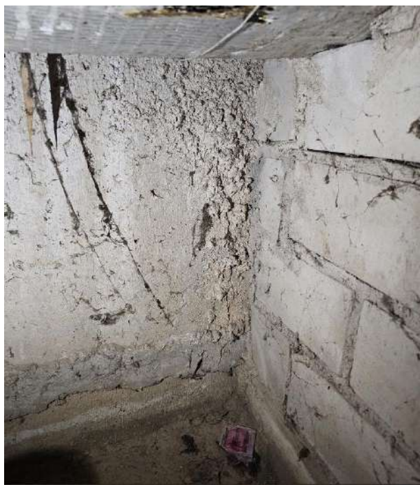
10 pav. Pamato vidinė pusė - stebima patvanka.
