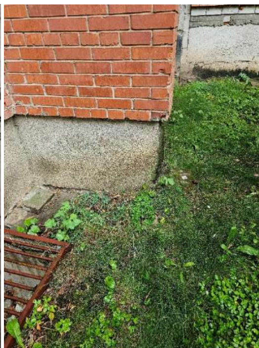
11 pav. Pamatas išorėje drėksta.
