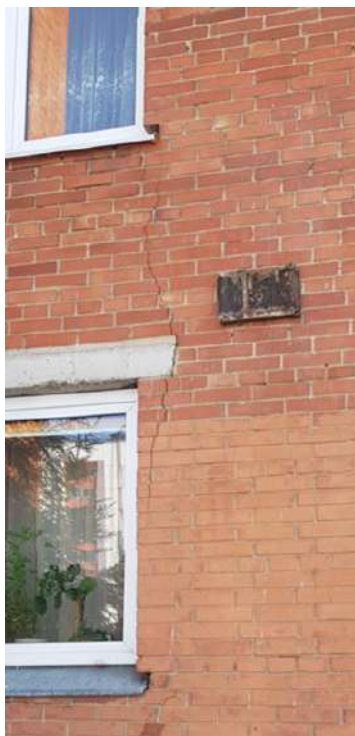
21 pav. Matomi trūkiai sienų angokraščiuose
