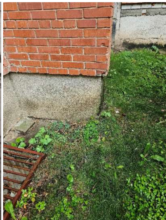
11 pav. Pamatas išorėje drėksta.
