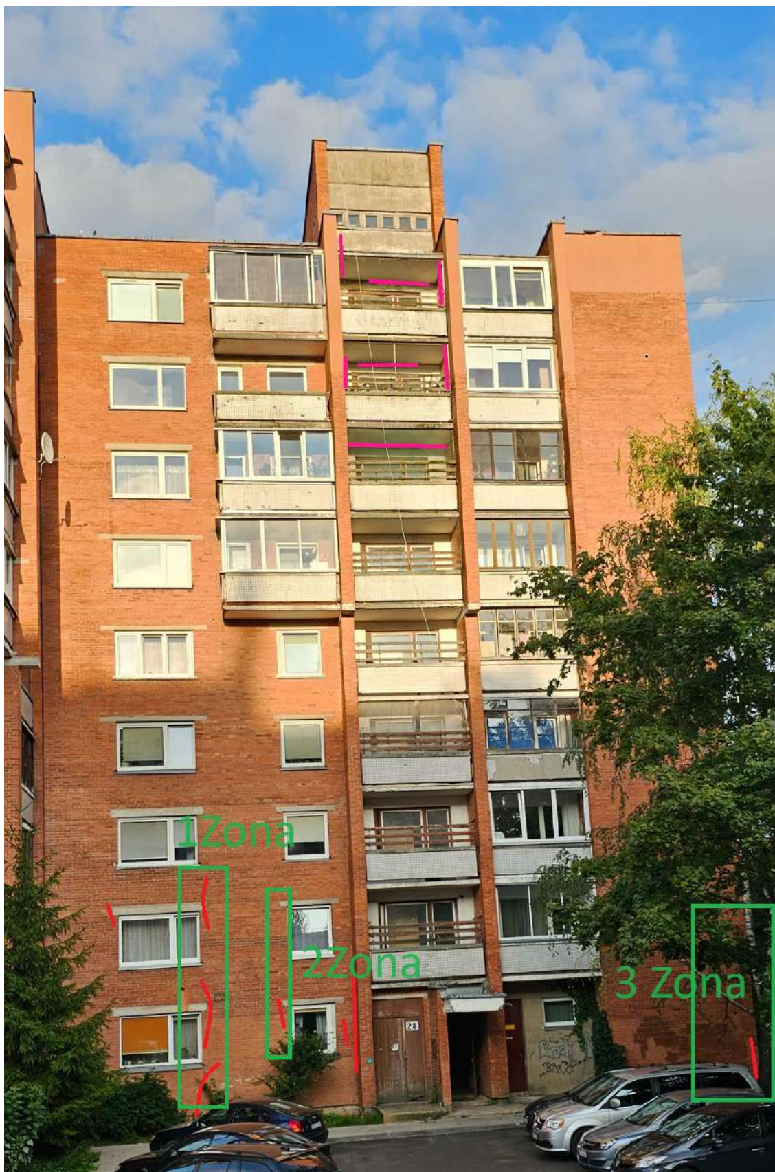
19 pav. Namas Nr.28, ašis A-A vakarinis fasadas, deformacijos pažymėtos raudonai. Žalias kvadratas – angkraščių stiprinimo zonos 1, 2,3 Zonos.
