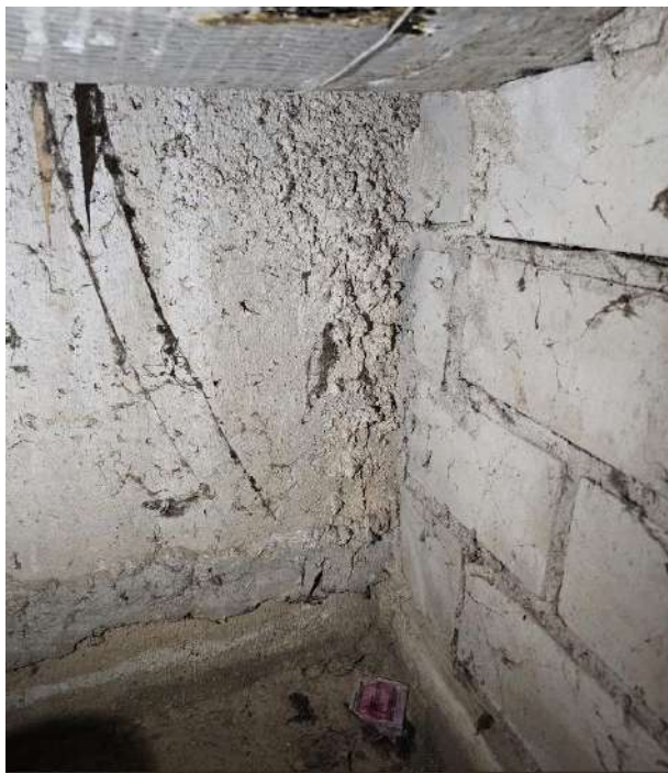
10 pav. Pamato vidinė pusė - stebima patvanka.
