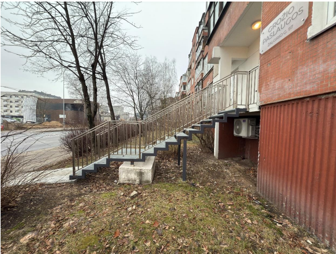
pav. 9 Įėjimas į komercines patalpas
