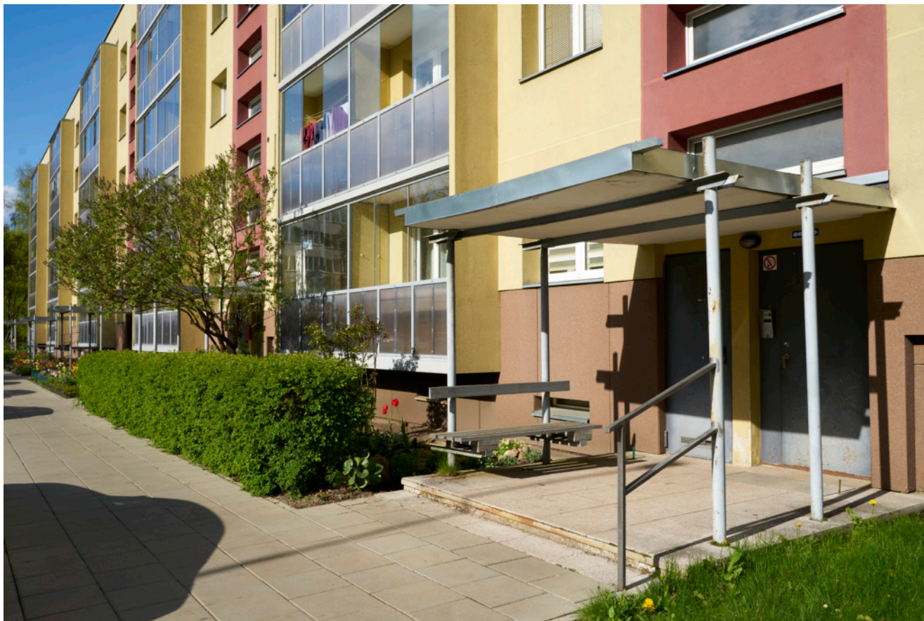
21 pav. 1-464A serijos stambiaplokščio penkių aukštų pastato jėjimai, paliktos senos stogelio konstrukcijos, metalinės koroduojančios kolonos, netvarkinga konstrukcija, Žirmūnai, Vilnius (fot. V. Buinevičius, 2023)
