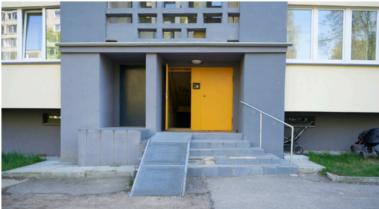
26 pav. 1-464LI serijos stambiaplokščio devynių aukštų pastato prieigose įrengiama per statį rampa, Žirmūnai, Vilnius (fot. V. Buinevičius, 2023)
