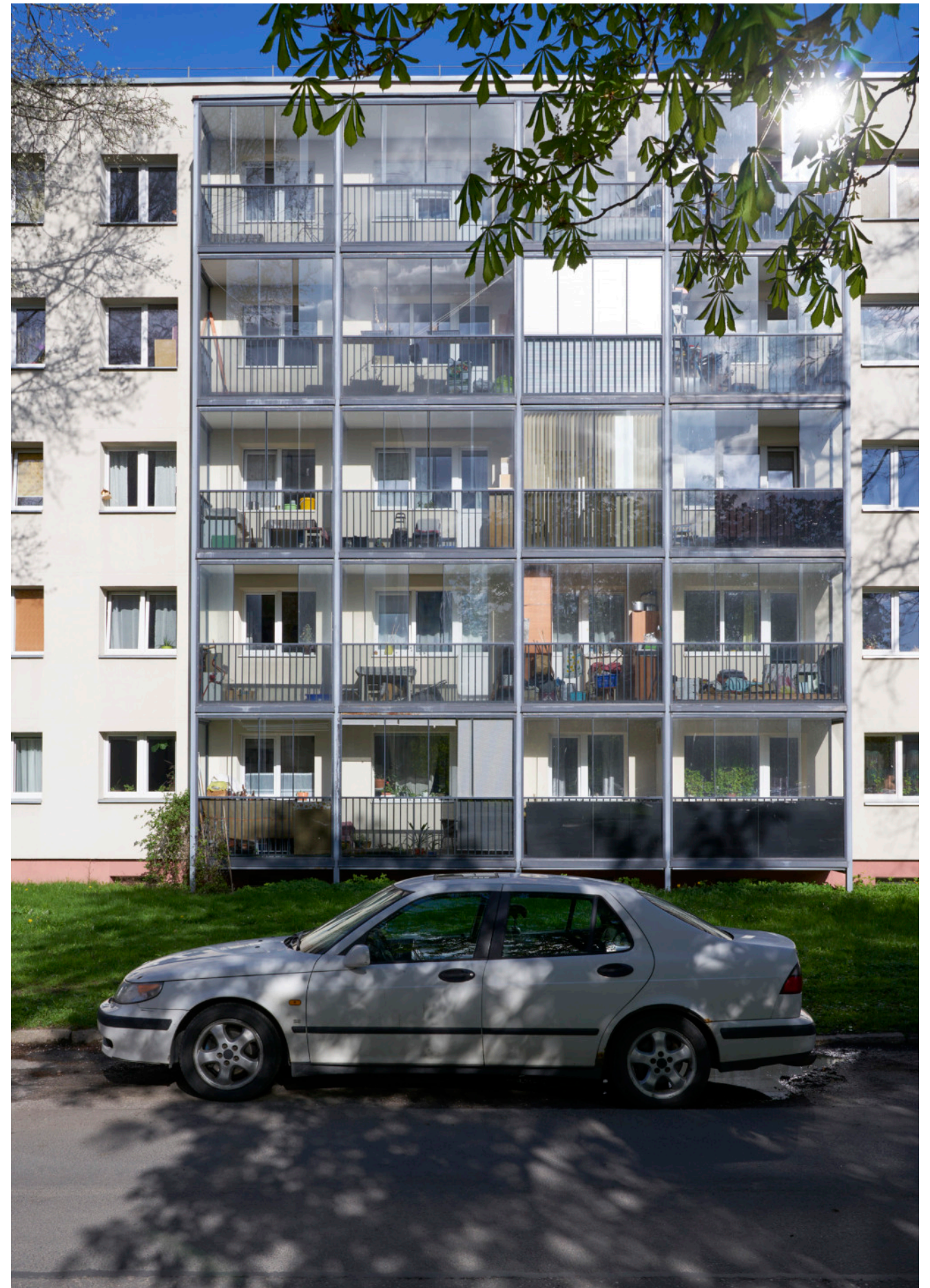
17 pav. 1-464A serijos stambiaplokščio penkių aukštų pastato renovuoti išplėsti ir berėme sistema įstiklinti balkonai, netvarkinga balkonų laikančiųjų elementų, skardinio ir stiklinimo detalizacija, naudojamos skirtingos spalvos ir medžiagos Žirmūnai, Vilnius (fot. V. Buinevičius, 2023)
