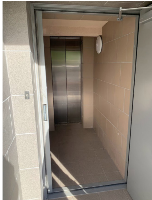
23 pav. 1-464LI serijos stambiaplokščio devynių aukštų pastato lifto pritaikymas geresniam pasiekiamumui įrengiant lifto holą buv. šiukšlių konteinerio patalpoje, Žirmūnai, Vilnius (fot. V. Buinevičius, 2023)
