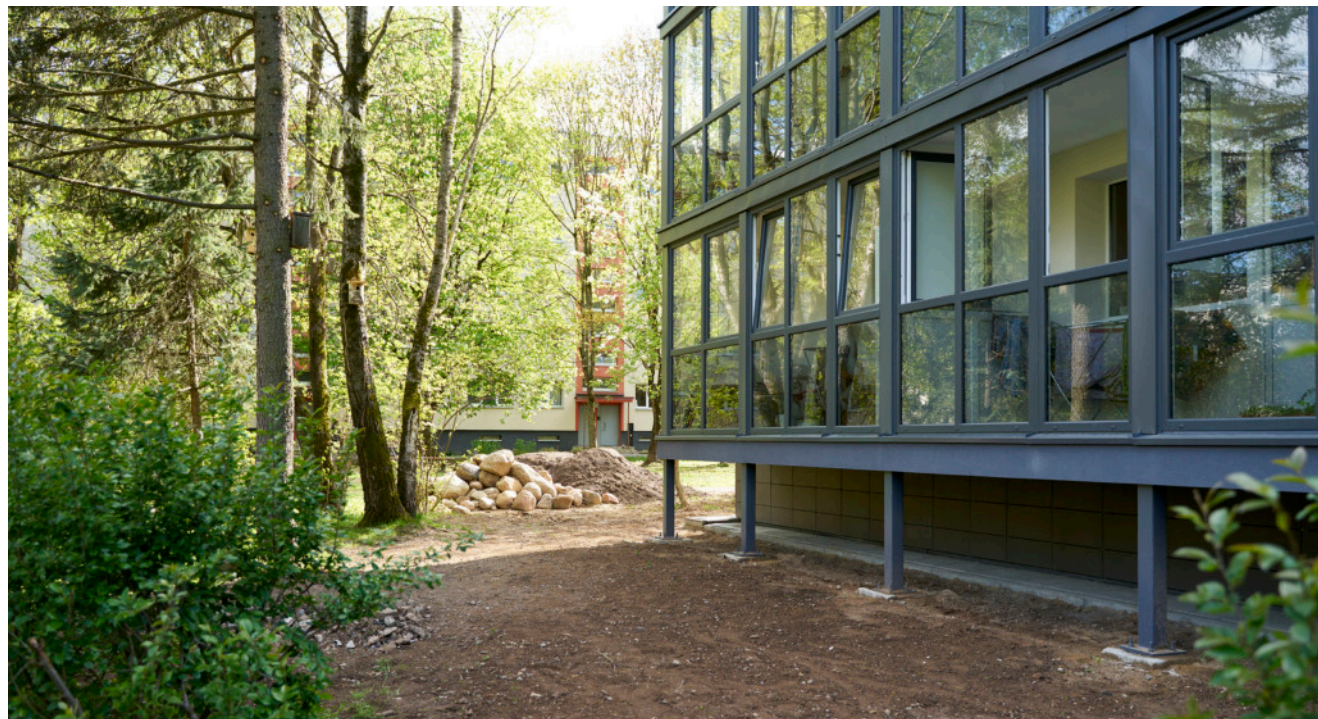
18 pav. 1-464A serijos stambiaplokščio penkių aukštų pastato renovuoti išplėsti ir šilta sistema įstiklinti balkonai, tvarkingas, vientisas sprendimas Žirmūnai, Vilnius (fot. V. Buinevičius, 2023)
