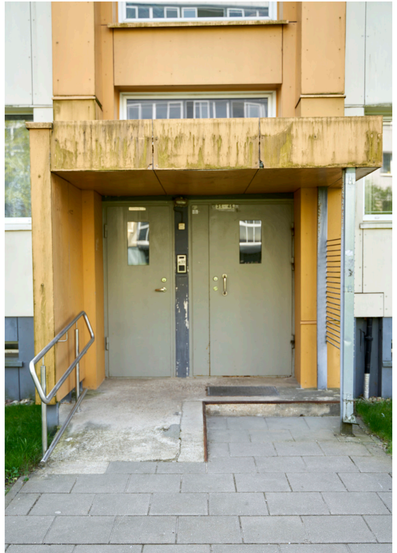
22 pav. 1-464A serijos stambiaplokščio penkių aukštų pastato jėjimai apdailinti firocemento plokštėmis nekokybiškos detalės, plyšiai, ir matomas tvirtinimas, Žirmūnai, Vilnius (fot. V. Buinevičius, 2023)
