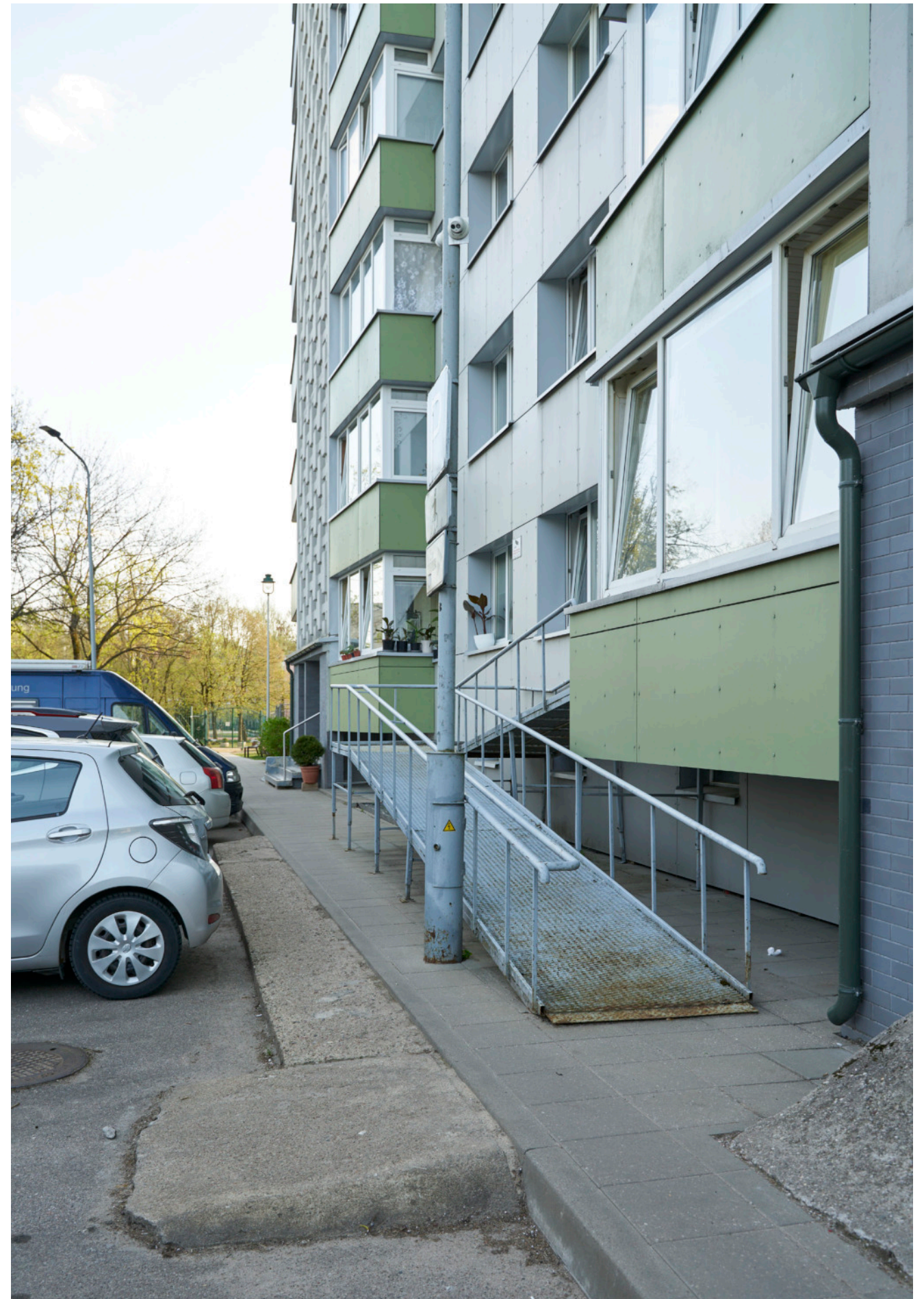
27 pav. 1-464LI serijos stambiaplokščio devynių aukštų pastato prieigose įrengiama rampa. Dėl siaurų prieigų pilnai užblokuojamas pėsčiųjų praėjimas, Žirmūnai, Vilnius (fot. V. Buinevičius, 2023)
