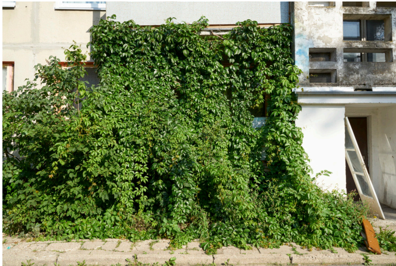
7 pav. 1-464LI serijos stambiaplokščio devynių aukštų daugiabučio namo balkonai iš priegių pusės, Lazdynai, Vilnius (fot. V. Buinevičius, 2023)
