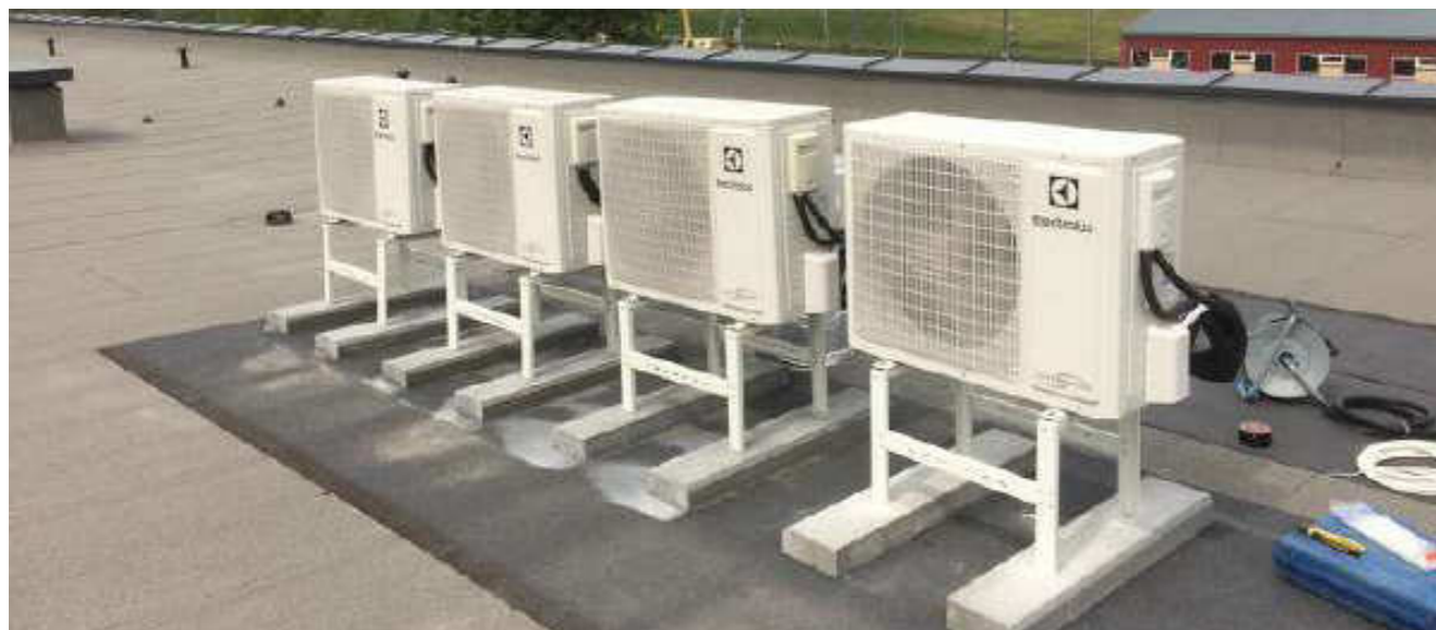
43 pav. Kondicionierių lauko blokai montuojami ant namo stogo
