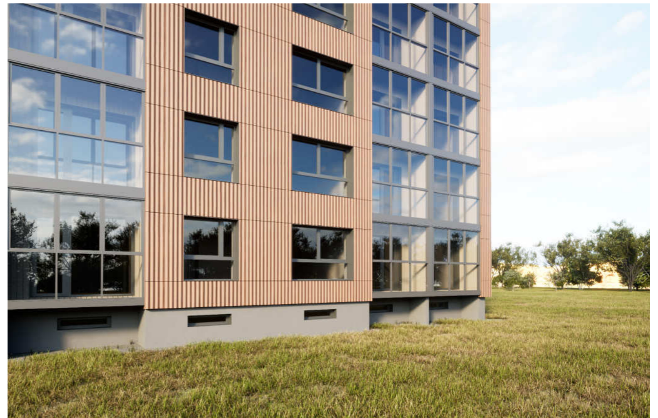
Vizualizacija: 1-464LI serijos pastato nepadidintų lodžijų stiklinimas šilta sistema, turėklo funkciją atlieka fiksuota apatinė stiklinimo sistemos dalis
