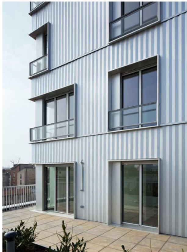
34 pav. Profiliuotų metalo lakštų fasado apdaila, daugiabutis namas, Plein Ciel, MG-AU ir Michel Guthmann Architecture et Urbanisme (fot. Takuji Shimmura, 2016)
