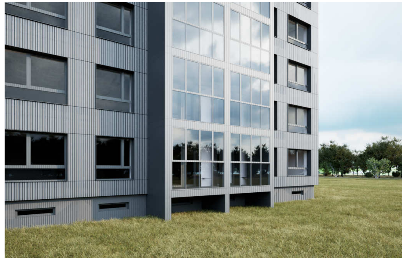
Vizualizacija: 1-464A serijos pastato padidintų balkonų stiklinimas šilta sistema, balkono šonai uždari, turėklo funkciją atlieka fiksuota apatinė stiklinimo sistemos dalis
