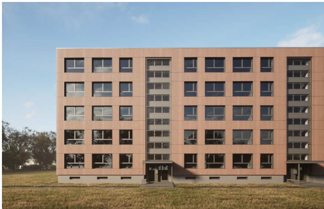
Vizualizacija: 1-464LI serijos pastato prieigų fasadas, nepadidinti laiptinių langai, langų nišos uždengiamos ažūriniu plieno tinklu
