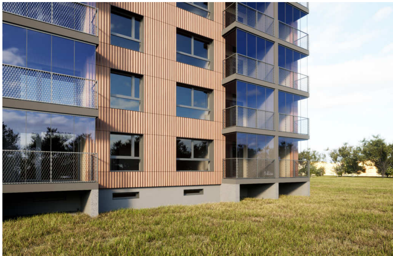
Vizualizacija: 1-464LI serijos pastato padidintų lodžijų stiklinimas šalta berėme sistema, iš išorės montuojami nerūdijančio plieno tinklo turėklai
