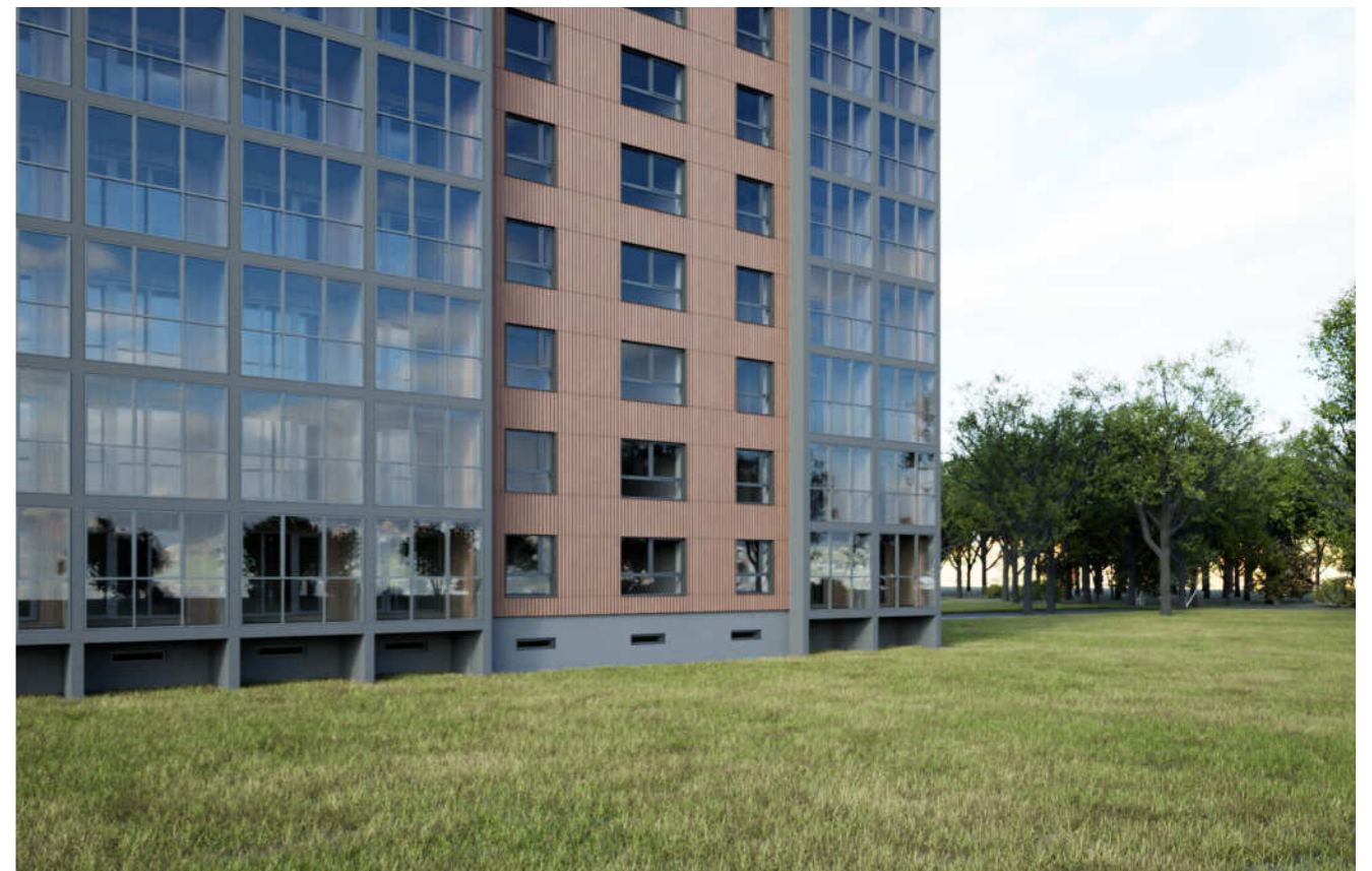
Vizualizacija: 1-464LI serijos 9a. pastato padinintų lodžijų stiklinimas šalta berėme sistema, lodžijų šonai uždari, turėklo funkciją atlieka fiksuota apatinė stiklinimo sistemos dalis
