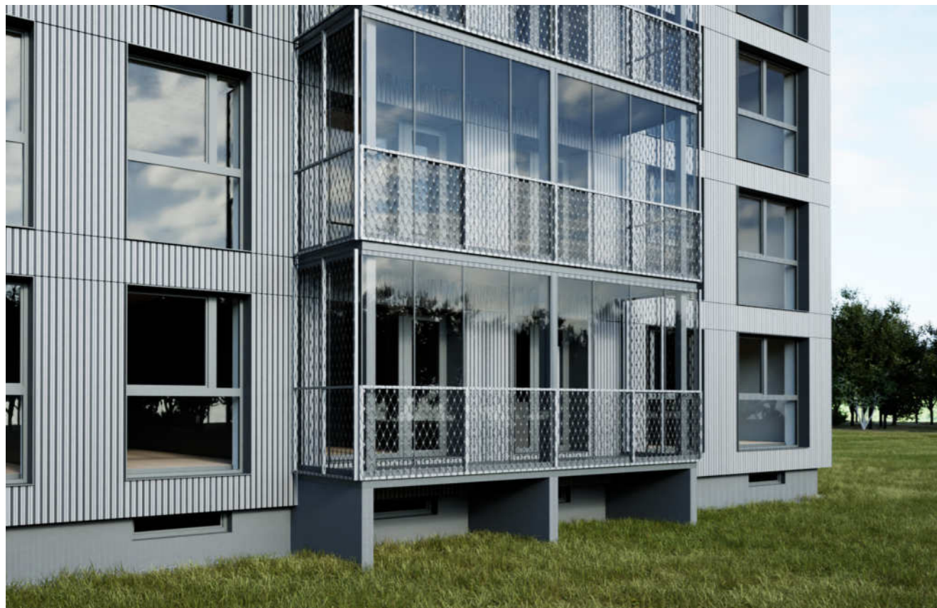
Vizualizacija: 1-464A serijos pastato padidintų balkonų stiklinimas šalta berėme sistema, iš išorės montuojami nerūdijančio plieno tinklo turėklai
