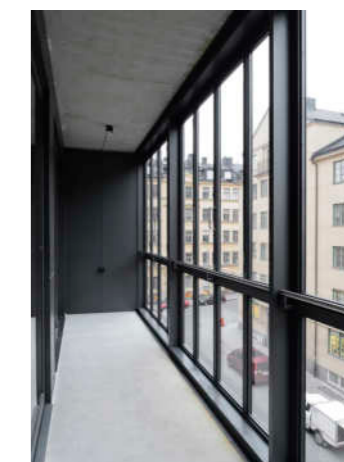
10 pav. „Šilta“ stumdoma aliuminio sistema, Jägnefält Milton architektai, (fot. Mikael Olsson, 2016)
