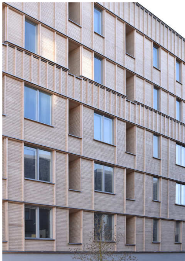
36 pav. Medinių konstrukcijų daugiabutis namas Upsalėje (Švedija) ÖSB Housing, Scott Rasmusson Källander (fot. Scott Rasmusson Källander, 2020)
