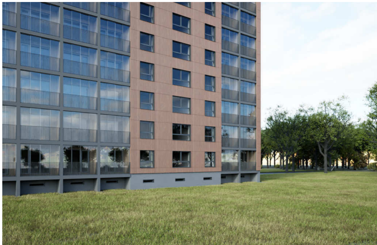
Vizualizacija: 1-464LI serijos 9a. pastato nepadintų lodžijų stiklinimas šalta berėme sistema, iš išorės montuojami vertikalių metalo juostų turėklai
