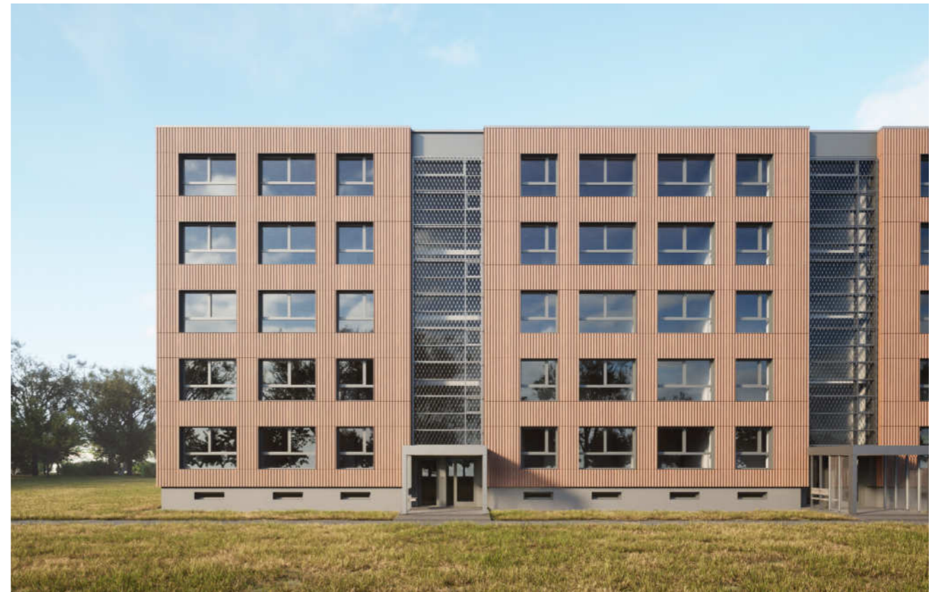
Vizualizacija: 1-464LI serijos pastato prieigų fasadas, padidinti laiptinių langai, langų nišos suformuojamos iki parapeto viršaus (sudalinamas pastato tūris), uždengiamos plieno tinklu
