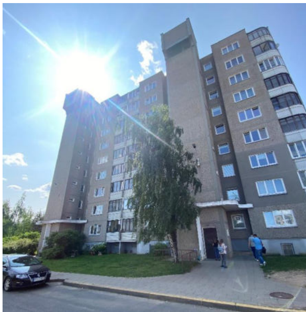
Pav. 1. Pastato šiaurinio fasado fotofiksacija
