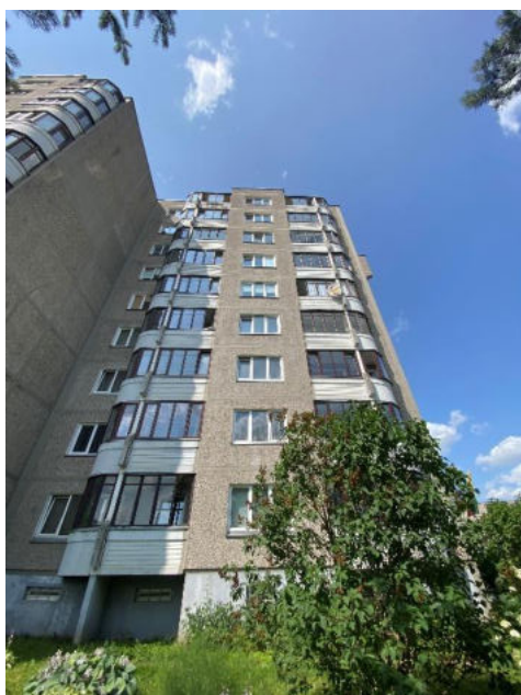
Pav. 3. Pastato rytinio fasado fotofiksacija
