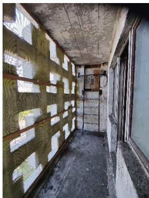
Pav. 8. Pastato bendro naudojimo balkonų vidaus fotofiksacija
