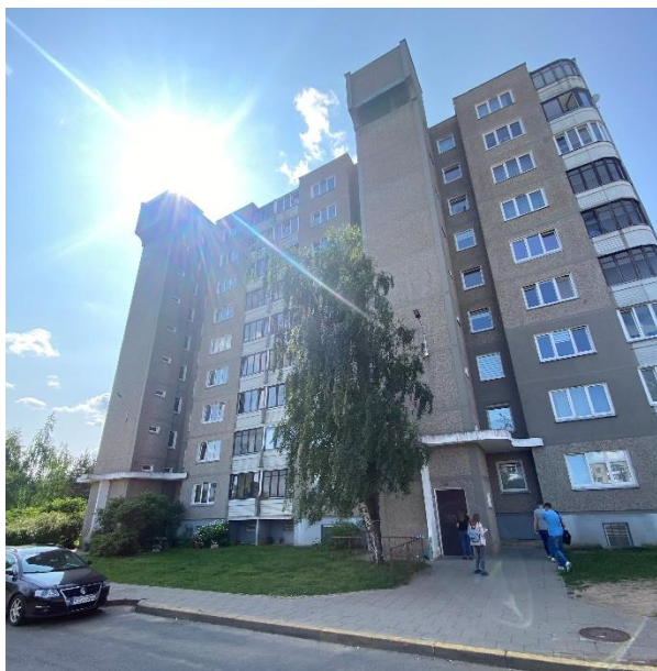
Pav. 3. Pastato šiaurinio fasado fotofiksacija
