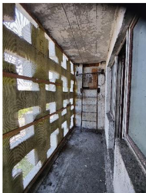
Pav. 8. Pastato bendro naudojimo balkonų vidaus fotofiksacija
