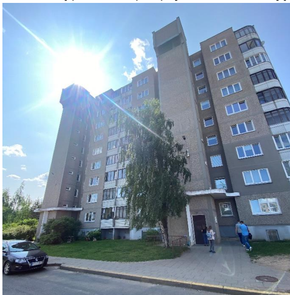
Pav. 1. Pastato šiaurinio fasado fotofiksacija
