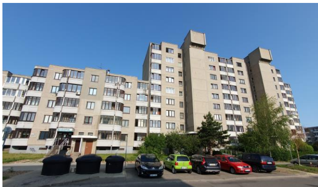
Pav. 3. Pastato rytinio fasado fotofiksacija
