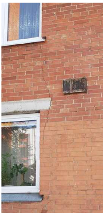
21 pav. Matomi trūkiai sienų angokraščiuose
