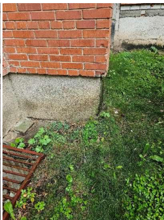
11 pav. Pamatas išorėje drėksta.
