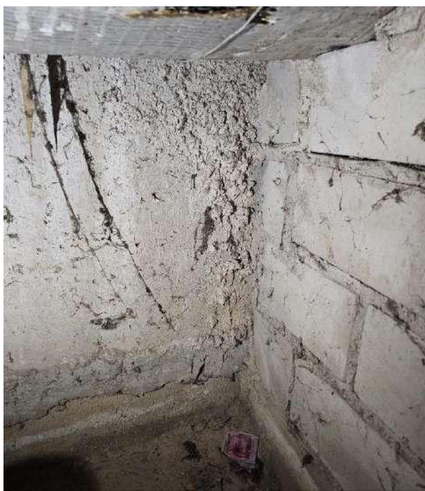
10 pav. Pamato vidinė pusė - stebima patvanka.
