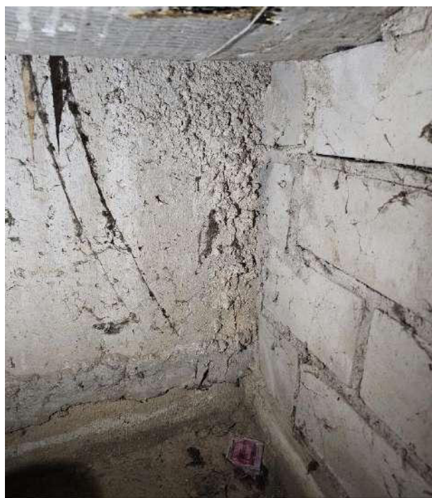
10 pav. Pamato vidinė pusė - stebima patvanka.
