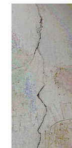
Pažeisto - supleišėjusio mūro tvirtinimo zonos
