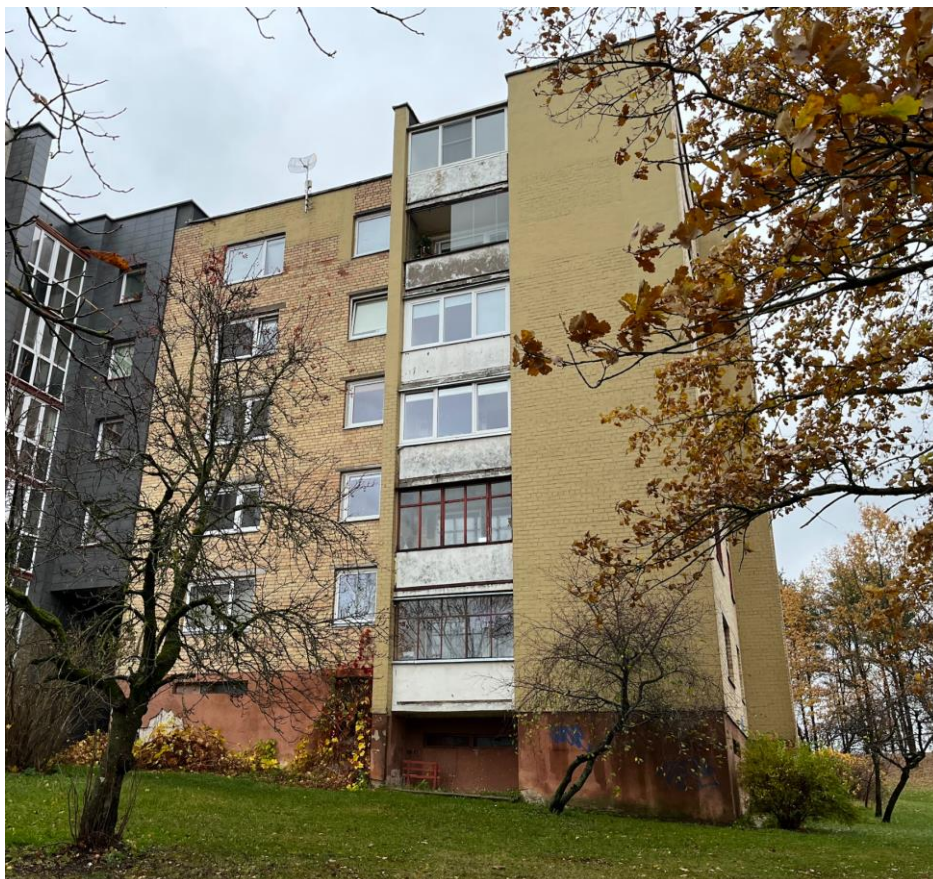
3 pav. „Fasado vaizdas iš vakarų pusės“
