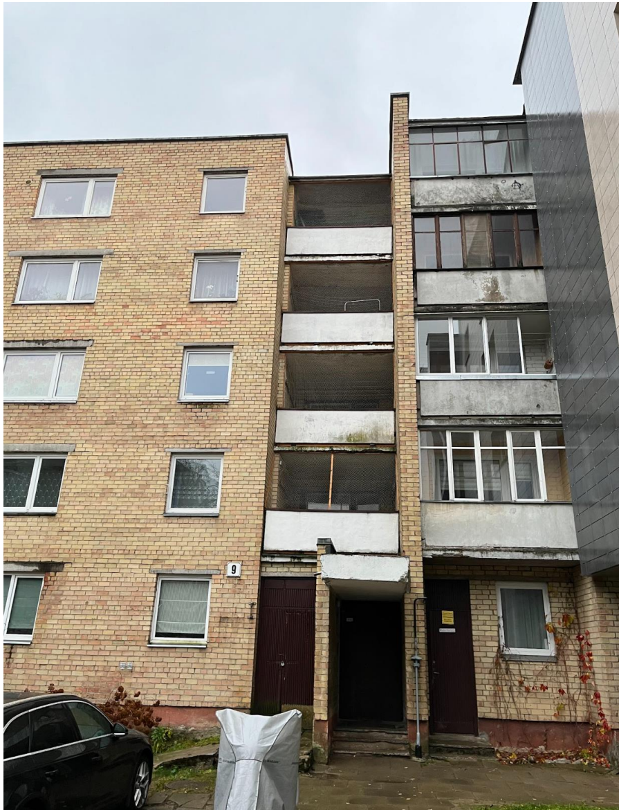
2 pav. „Fasado vaizdas iš įėjimo pusės“
