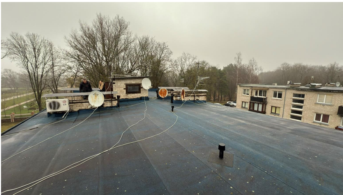
Pav. 13. Bendra stogo būklė
