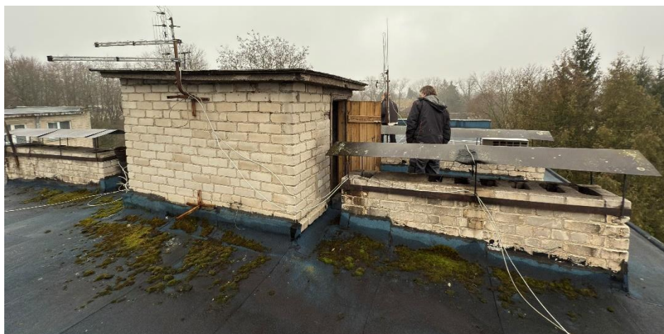
Pav. 16. Stogo defektai: apkerpėjusi danga
