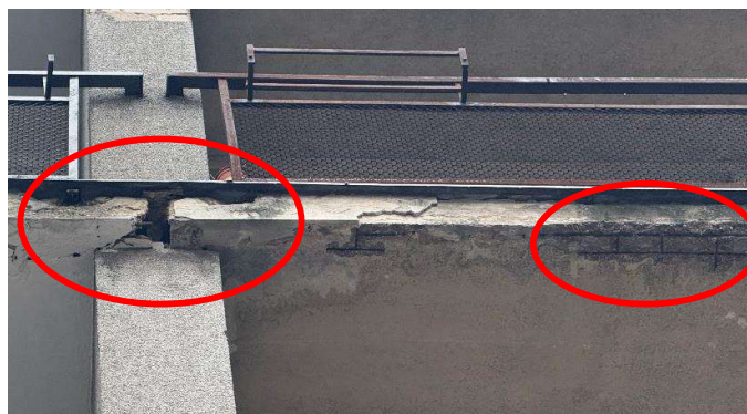
Pav. 18. Balkonų defektai: apskilinėjęs balkono perdangos plokštės betonas ir pažeistas apsauginis betono sluoksnis
