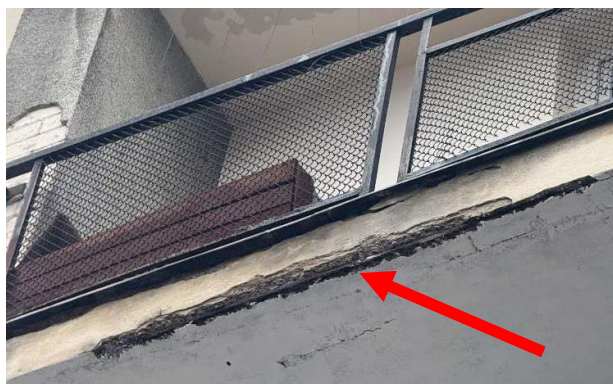
Pav. 18. Balkonų defektai: apskilinėjęs balkono perdangos plokštės betonas ir pažeistas apsauginis betono sluoksnis
