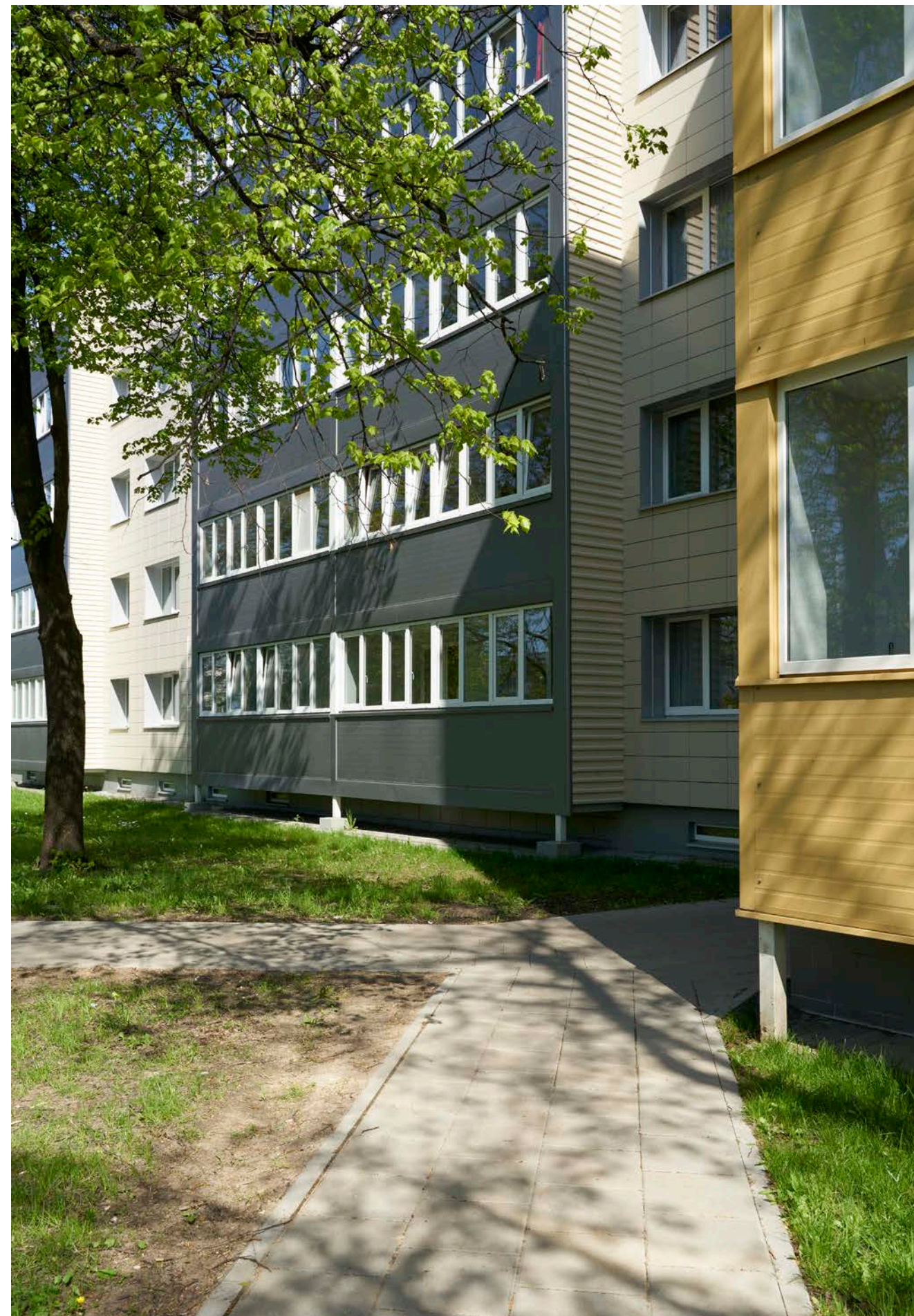
20 pav. 1-464A serijos stambiaplokščio penkių aukštų pastato balkonai apdailinti "sandwich" plokštėmis ir trapeicine skarda, Žirmūnai, Vilnius (fot. V. Buinevičius, 2023)
