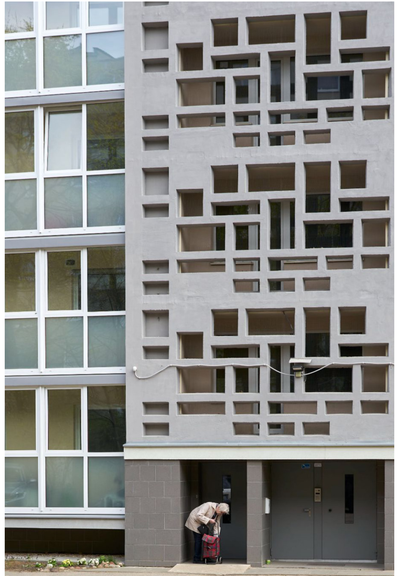
24 pav. 1-464LI serijos stambiaplokščio devynių aukštų pastato laiptinės fasadas, Žirmūnai, Vilnius (fot. V. Buinevičius, 2023)
