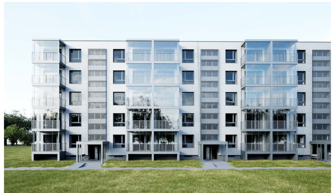
Vizualizacija: 1-464A serijos pastato prieigų fasadas, nepadidinti laiptinių langai, laiptinės langų nišos uždengiamos plieno tinklu
