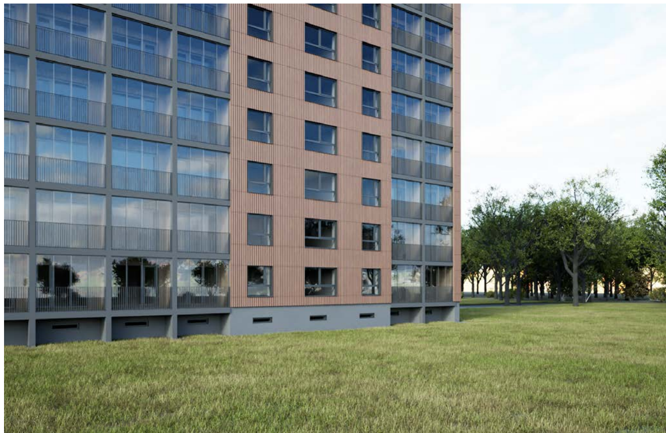
Vizualizacija: 1-464LI serijos 9a. pastato nepadidintų lodžijų stiklinimas šalta berėme sistema, iš išorės montuojami vertikalių metalo juostų turėklai
