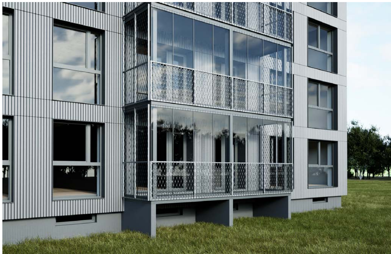
Vizualizacija: 1-464A serijos pastato padidintų balkonų stiklinimas šalta berėmė sistema, iš išorės montuojami nerūdijančio plieno tinklo turėklai
