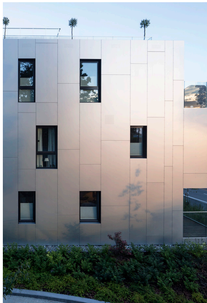
33 pav. Aliuminio kompozito fasado pavyzdys, Sæter Terrasse, A-lab (fot. Ivan Brodey)
