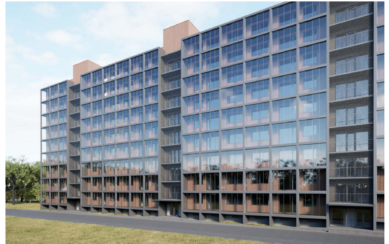
Vizualizacija: 1-464LI serijos 9 a. pastato prieigų fasadas, vietoje dekoratyvios betono plokštės, montuojamas azūrinis nerūdijančio plieno tinklo (balkonų) fasadas
