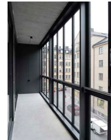
10 pav., „Šilta“ stumdoma aliuminio sistema, Jägnefält Milton architektai, (fot. Mikael Olsson, 2016)
