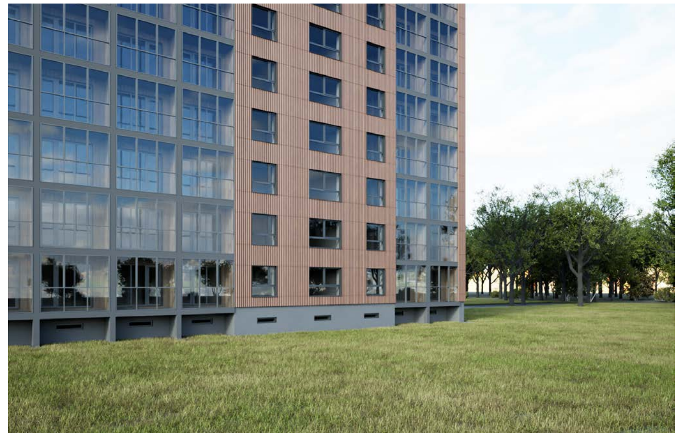
Vizualizacija: 1-464LI serijos 9a. pastato nepadidintų lodžijų stiklinimas šilta sistema, turėklo funkciją atlieka fiksuota apatinė stiklinimo sistemos dalis
