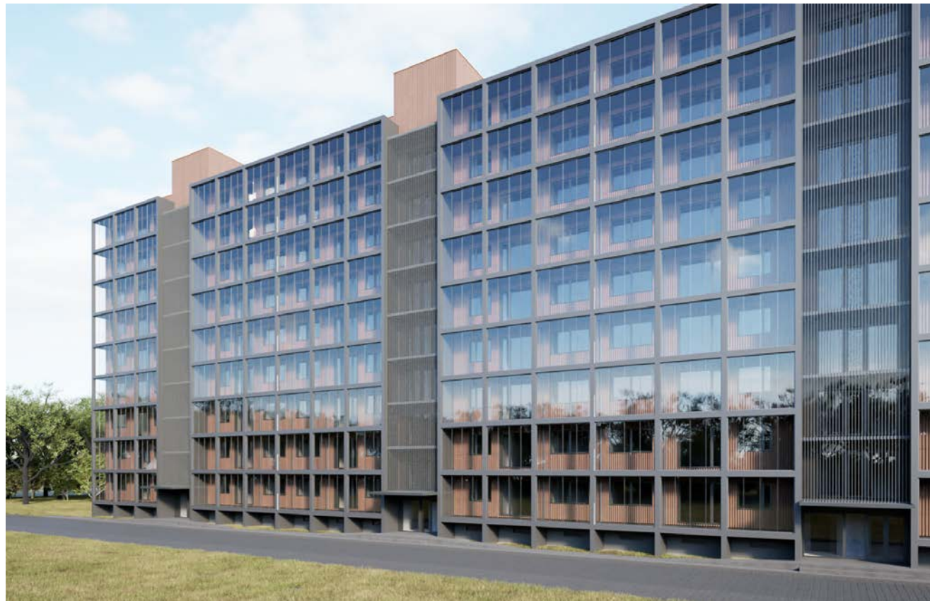
Vizualizacija: 1-464LI serijos 9 a. pastato prieigų fasadas, vietoje dekoratyvios betono plokštės, montuojamas azūrinis vertikalių aliuminio profilių laiptinės (balkonų) fasadas
