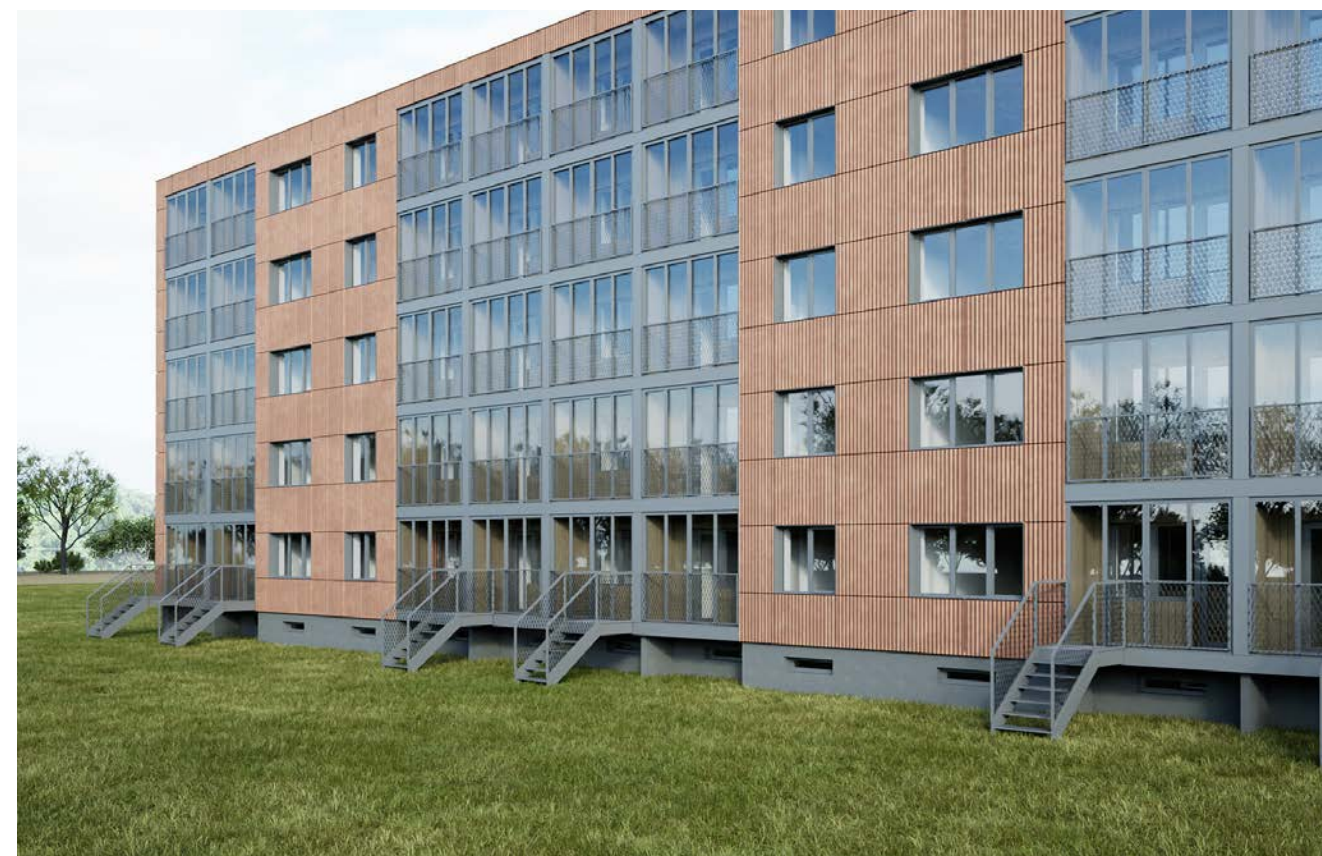
Vizualizacija: tipinio 1-464LI-17/1 pastato balkono laiptelių dizaino pasiūlymas, vaizdas iš kiemo pusės. Variantas 1: Kompaktiški laipteliai.
