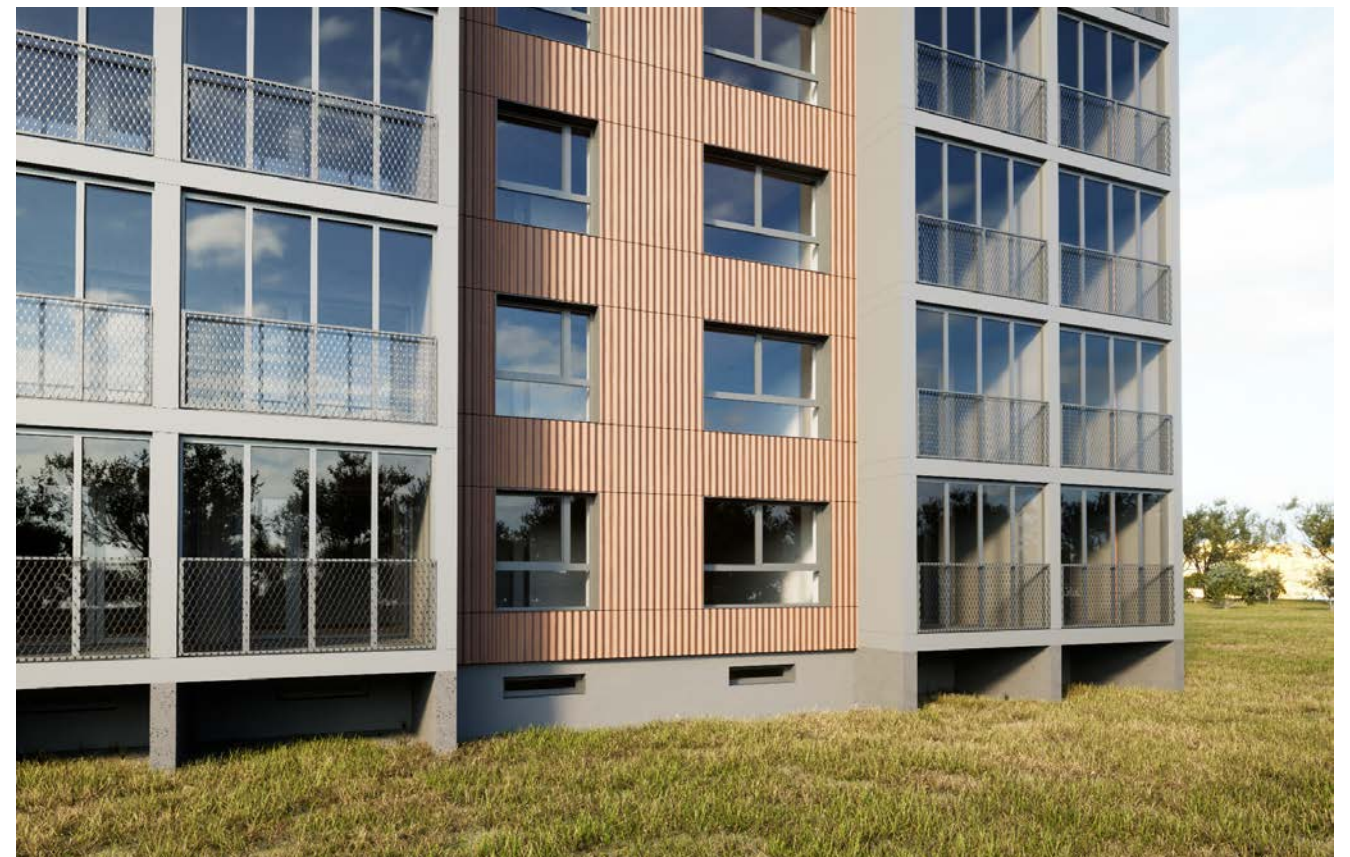
Vizualizacija: 1-464LI serijos pastato padidintų lodžijų stiklinimas šilta sistema, uždari lodžijų šonai, turėklo funkciją atlieka fiksuota apatinė stiklinimo sistemos dalis
