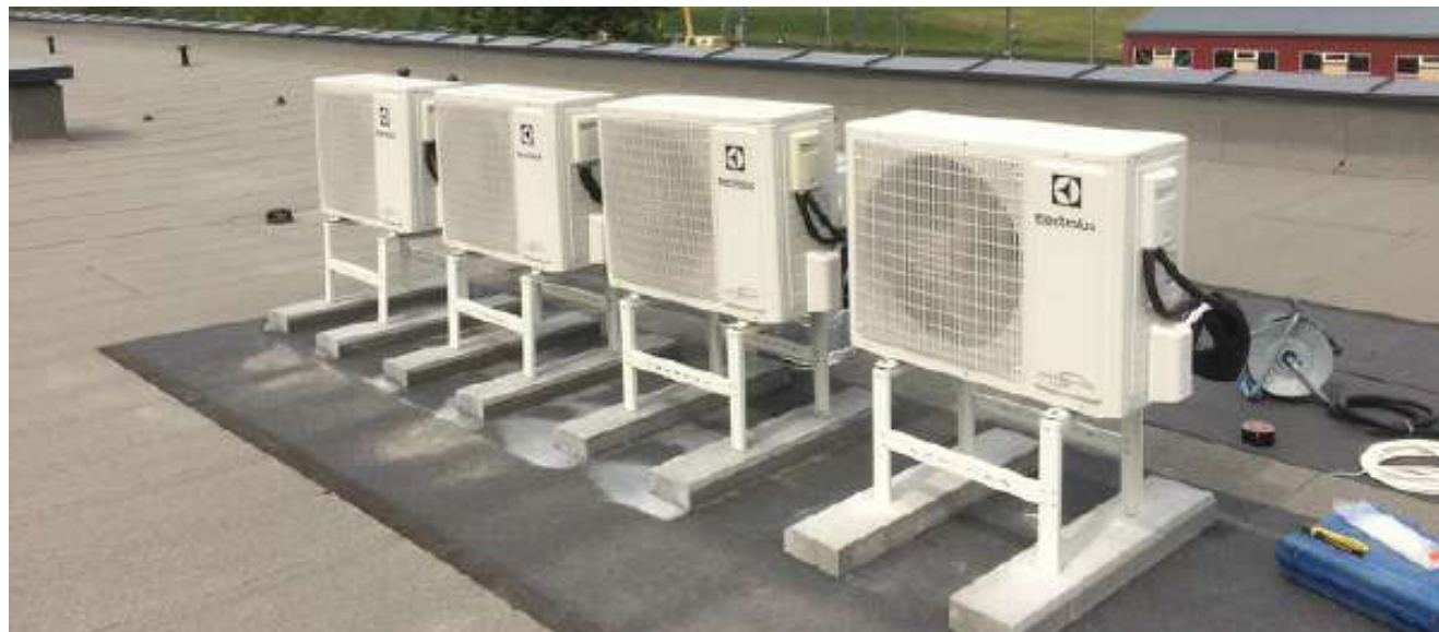
Kondicionierių lauko blokai montuojami ant namo stogo
