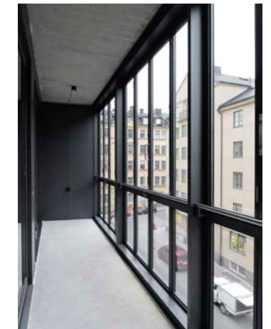
„Šilta“ stumdoma aliuminio sistema, Jägnefält Milton architektai, (fot. Mikael Olsson, 2016)
