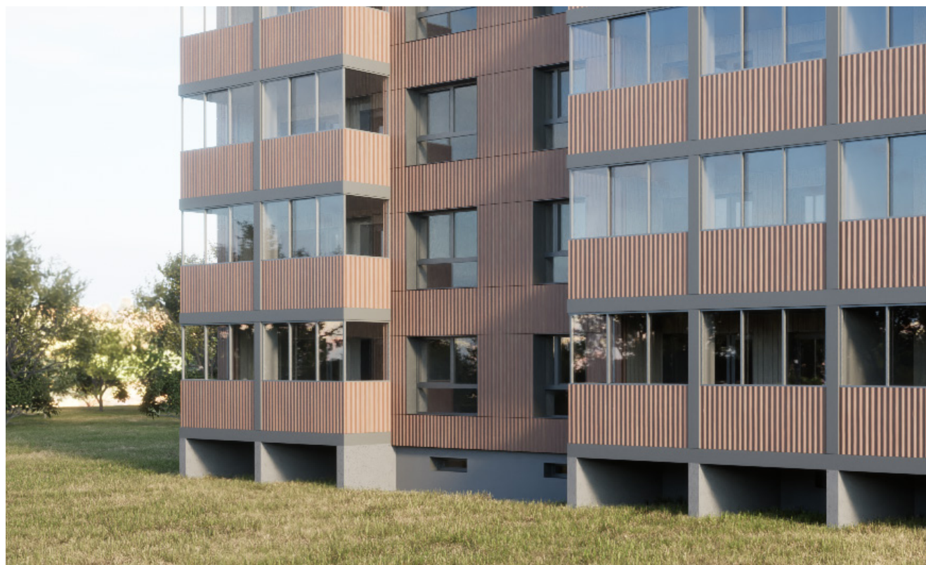
Vizualizacija: uždaro tipo turėklas iš keraminės fasado apdailos (4)
