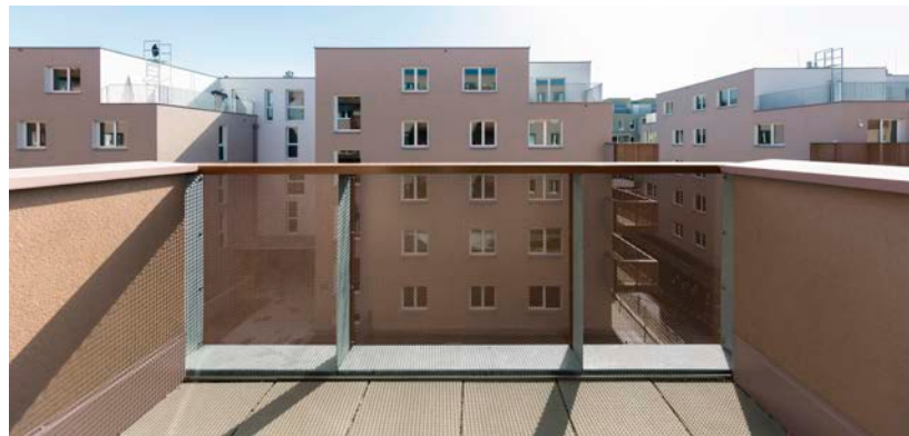
Ažūriniai balkonų turėklai, pagaminti iš smulkiai perforuotos skardos, SCH Housing An Den Schichtgründen, trans_city TC architektai (fot. Daniel Hawelka 2020)
