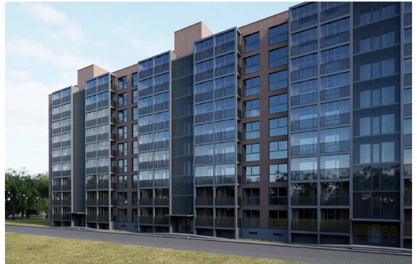
Vizualizacija: G. Balkonų ilgio padidinimas iki 6 m (per 2 patalpas), gylis padidinamas nuo 100 cm iki 150 cm
