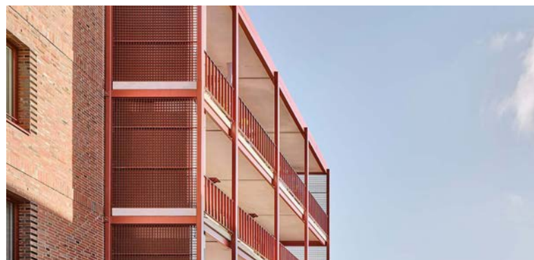
Ažūriniai balkonų turėklai, pagaminti iš smulkiai perforuotos skardos, SCH Housing An Den Schichtgründen, trans_city TC architektai (fot. Daniel Hawelka 2020)
