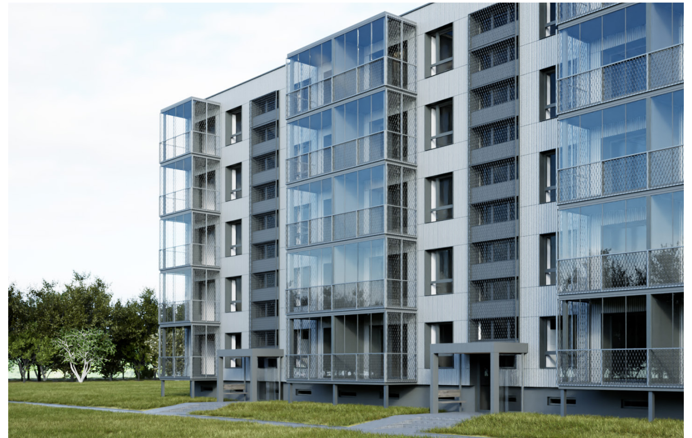
Vizualizacija: A. Balkono gylis padidinamas nuo 80 cm iki 150 cm, ilgis – per 2 patalpas
