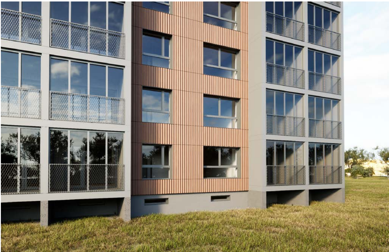
Vizualizacija: balkonų stiklinimas „šilta“ sistema su aklinais šonais (padidintas lodžijų gylis)
