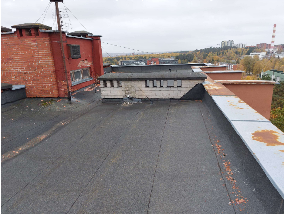
Stogas: Stogas - sutapdintas, dengtas prilydoma bitumine danga. Lietaus nuvedimas vidinis.
