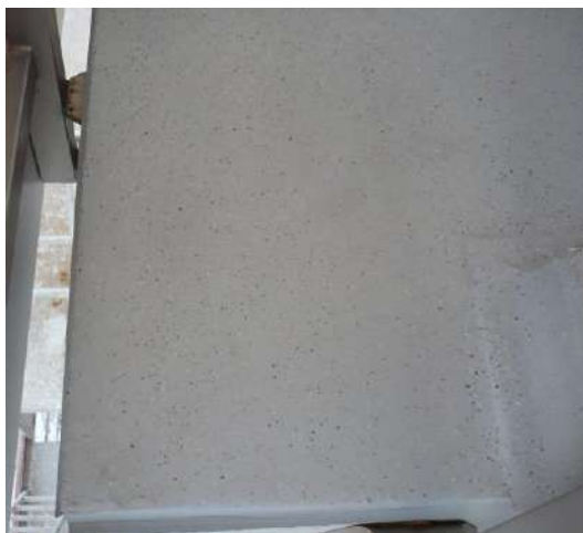
Pav. 4 Užbaigto paviršiaus vaizdas
