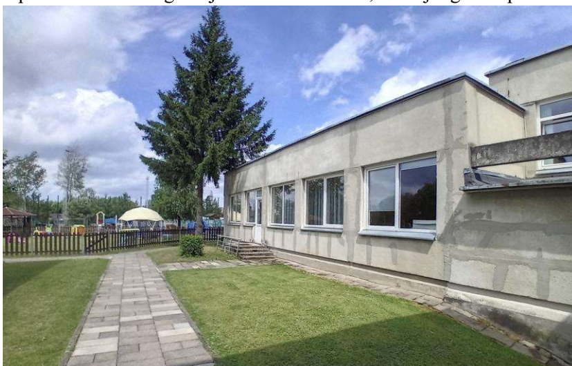
5 pav. Išėjimas iš salės į lauką per išorinius laiptus, įrengtus dėl 1 aukšto grindų ir žemės aukščių skirtumo.
