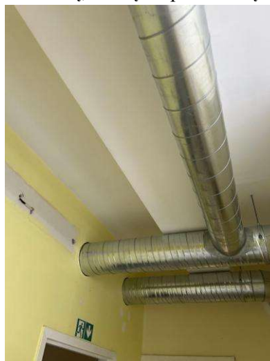
3 pav. Vėdinimo įrenginiai bus keičiami naujais. Esami sprendiniai neatitinka keliamų reikalavimų.
