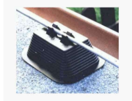
Laidiniko d-8mm. montavimas ant pastato stogo dangos
