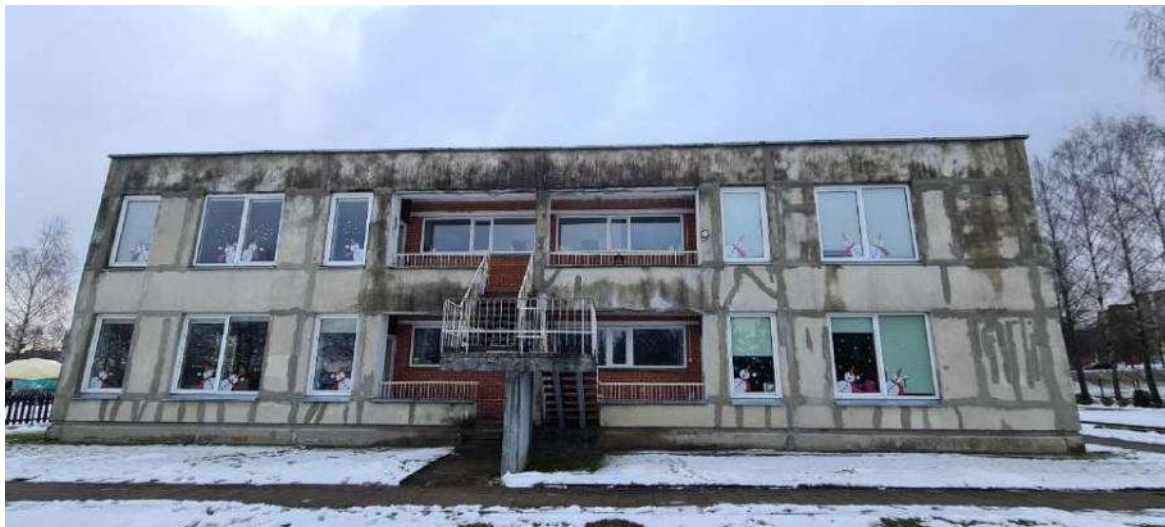
Nuotrauka Nr. 7 Fasadinių dujų silikato plokščių apatinėje dalyje nuo drėgmės ir šalčio poveikio nukritusi dujų silikato, matoma korduojanti armatūra (keturios plokštės laiptų maršo dalyje)
