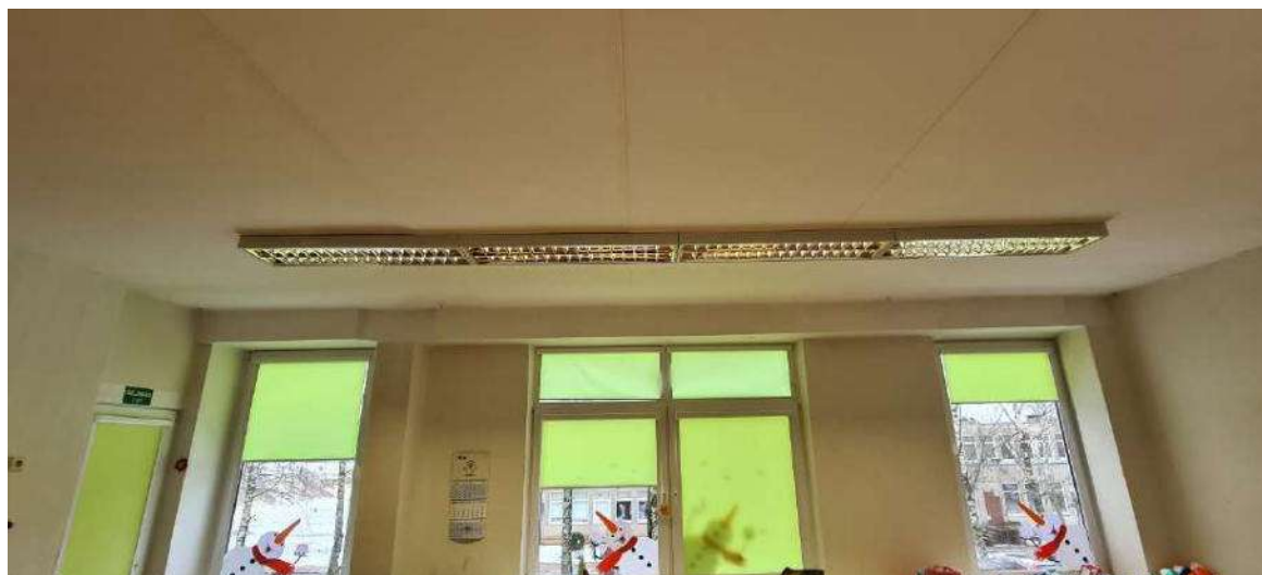
Nuotrauka Nr. 2 bendras statinio konstrukcijų vaizdas antrame aukšte
