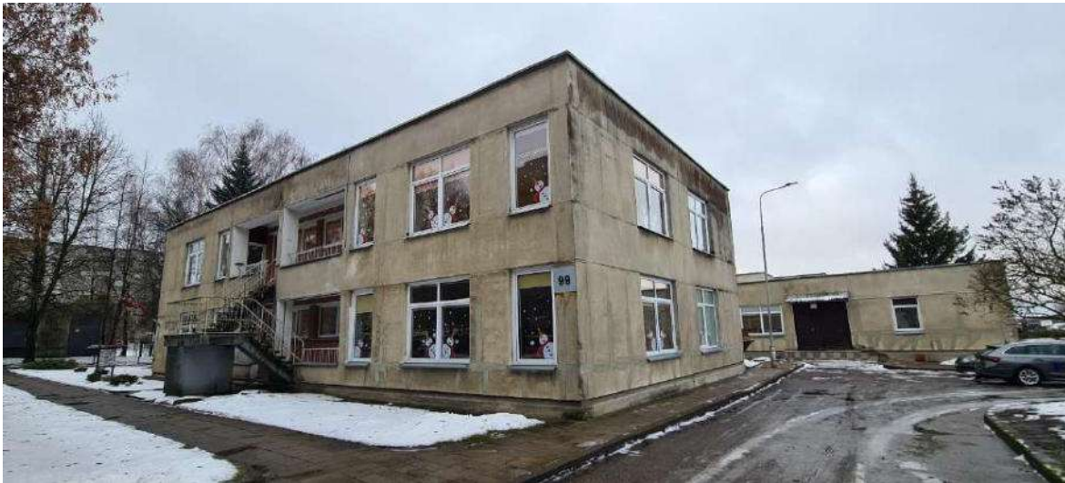
Nuotrauka Nr. 4 bendras statinio konstrukcijų vaizdas antrame aukšte
