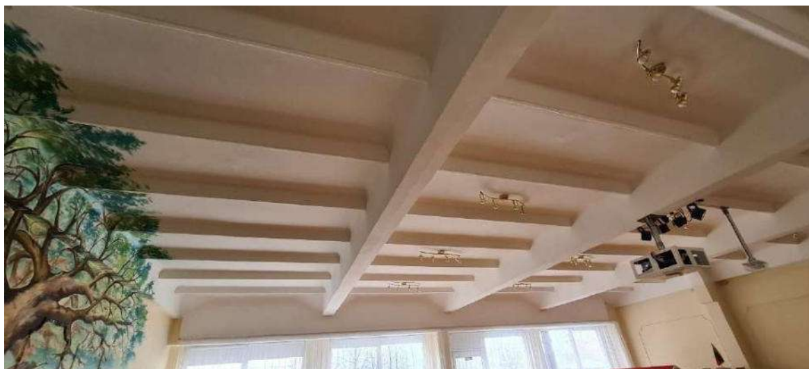
Nuotrauka Nr. 3 bendras statinio konstrukcijų aktų salėje
