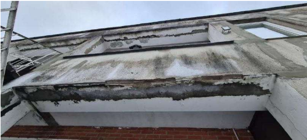
Nuotrauka Nr. 6 Fasadinių dujų silikato plokščių apatinėje dalyje nuo drėgmės ir šalčio poveikio nukritusi dalis dujų silikato, matoma korduojanti armatūra
