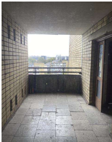
11. Pav. Durys į N1 tipo evakuacinę laiptinę netvarkingos, neatitinka gaisro saugos reikalavimų. Šalia N1 tip laiptinės balkonų, už mūro sienos su angomis yra rūbų džiovyklos.
