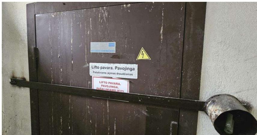
10. Pav. techninės patalpos apsaugotos metalinėmis arba apskardintomis durimis. Numatoma jas pakeisti į priešgaisrines, atitinkančias šiai dienai keliamus reikalavimus.
