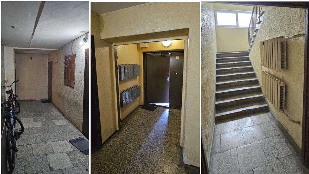
13. Pav. Koridoriuose įrengtos el. apskaitos spintos, apšvietimas šviečia nuo judesio. Durys butų dauguma šarvo tipo. Patekimui į pastatą plačios dvivėrės durys, beveik koridoriaus pločio. N1 tip laiptinėje laiptai 1,3 m pločio. Radijatoriai laiptinėje prakiurę. Gaisro aptikimo ir signalizavimo sistemos nėra.
