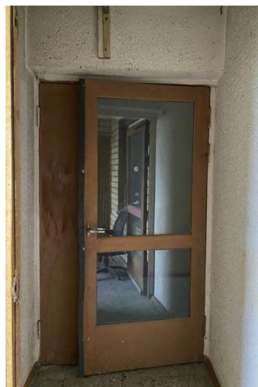
11. Pav. Durys į N1 tipo evakuacinę laiptinę netvarkingos, neatitinka gaisro saugos reikalavimų. Šalia N1 tip laiptinės balkonų, už mūro sienos su angomis yra rūbų džiovyklos.
