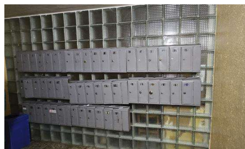
12. Pav. Liftų holai nuo koridorių aukštuose atskirti stiklo blokelių pertvaromis, pirmame aukšte ant jos įrengtos pašto dėžutės. Pertvaros atrodo tvarkingos, turėtų laikyti EI 45.
