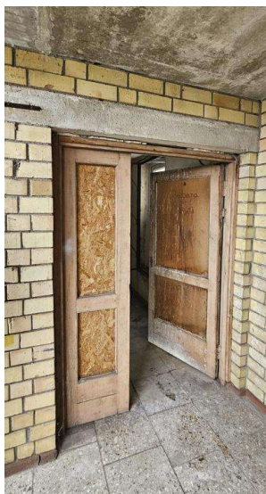
11. Pav. Durys į N1 tipo evakuacinę laiptinę netvarkingos, neatitinka gaisro saugos reikalavimų. Šalia N1 tip laiptinės balkonų, už mūro sienos su angomis yra rūbų džiovyklos.
