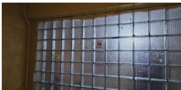
12. Pav. Liftų holai nuo koridorių aukštuose atskirti stiklo blokelių pertvaromis, pirmame aukšte ant jos įrengtos pašto dėžutės. Pertvaros atrodo tvarkingos, turėtų laikyti EI 45.
