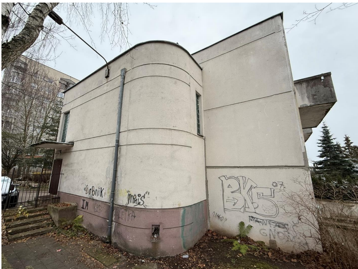
Pav. 7. Pastato fasadas
