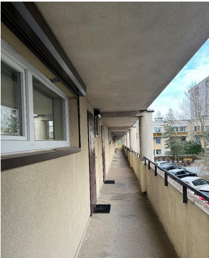
Pav. 14. Bendra galerijos būklė
