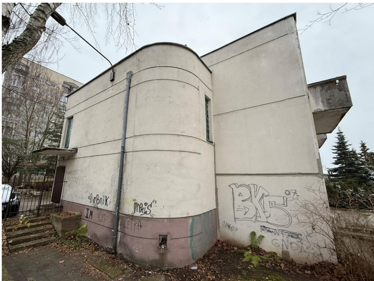
Pav. 7. Pastato fasadas
