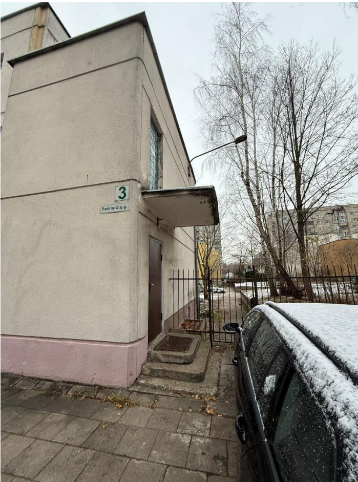
Pav. 19. Stogo defektai: bendra jėjimo būklė
