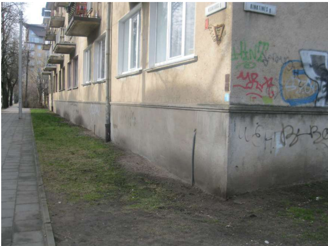
12 ir 13 pav. Nuogrinda vietomis nėra įrengta, ko pasekoje drėksta namo pamatai.
