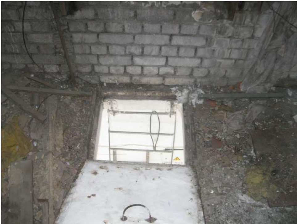
23 pav. Užlipimo ant stogo liuko sienelės yra per žemos ir netenkina gaisrinės saugos reikalavimų. Liuko dangtis neapšiltintas, todėl patiriami šilumos nuostoliai.
