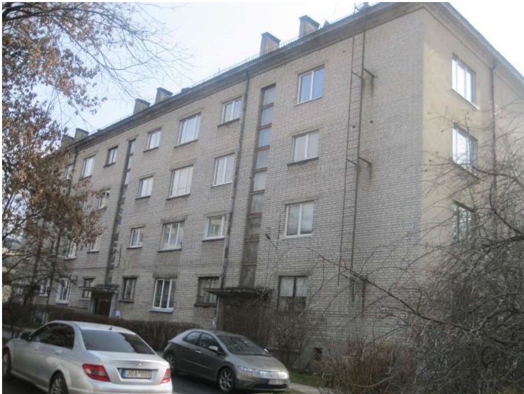
2 pav. Kiemo pusės (šiaurinio) pastato fasado bendras vaizdas. Didžioji dalis pastato langų pakeisti į naujus plastikinius. Pastato fasadas atrodo pakankamai tvarkingai.
