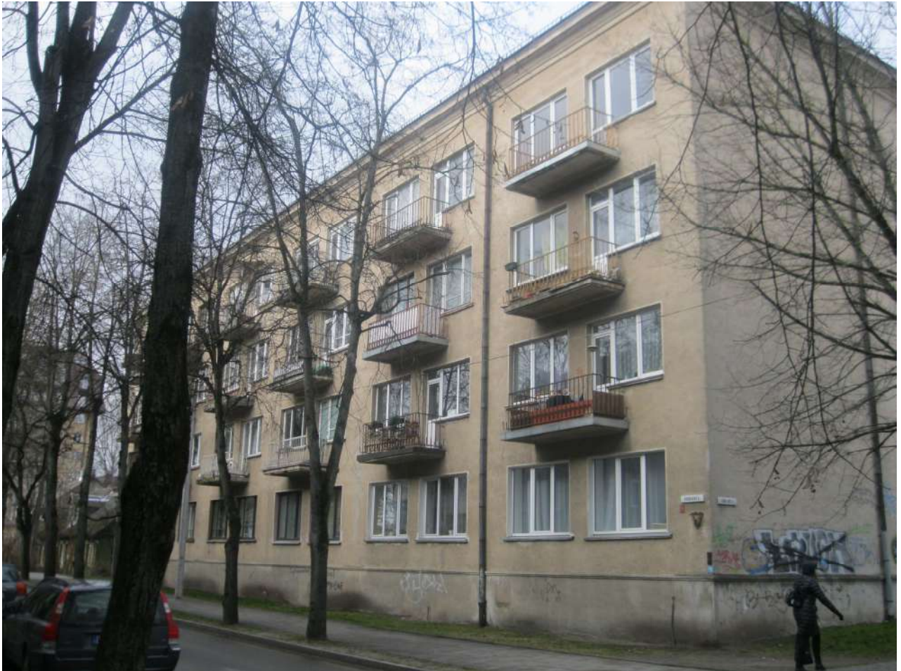
1 pav. Bendras pagrindinio (pietinio) pastato fasado vaizdas. Dauguma pastato langų pakeisti į naujus plastikinius. Vietomis pastebėti pastato fasadų apdailos pažeidimai – plyšiai fasadų tinke; daugiausia matyti cokolinės pastato dalies pažeidimų - nutrupėjęs ar atšokęs tinkas, nusilupę dažai, įdrėkęs cokolio tinkas. Pirmo aukšto lygyje fasadai, ypač galiniai, išpaušyti graffiti.
