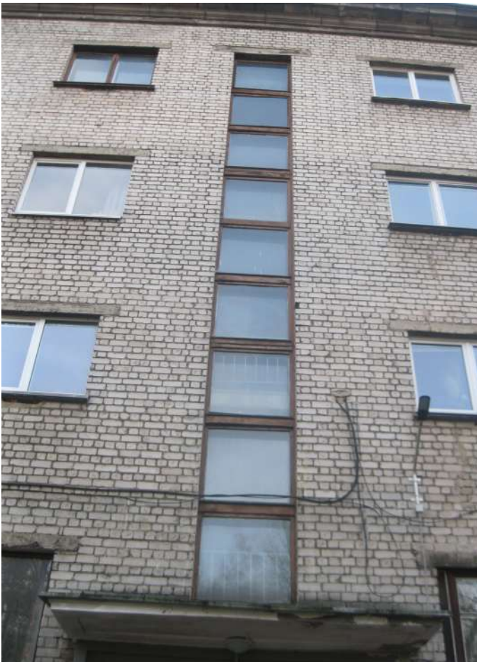
8 ir 9 pav. Bendras laiptinės langų vaizdas. Langų būklė prasta - langai nesandarūs, jų rėmai papuvę, išsikreivinę, kai kurie langų stiklai suskile, langus labai sunku, o kai kurių net neįmanoma, varstyti.
