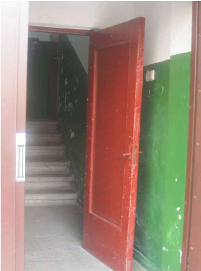
11 pav. Bendras senų medinių tambūro durų vaizdas. Durys senos, visiškai susidėvėjusios, nesandarios, sunkiai varstomos, blogai užsidaro. Durų šilumos perdavimo charakteristikos neatitinka STR 2.01.02:2016 „Pastatų energinio naudingumo projektavimas ir sertifikavimas“ reikalavimų. Namų gyventojai nepritarė siūlymui duris keisti, todėl jos paliekamos esamos.
