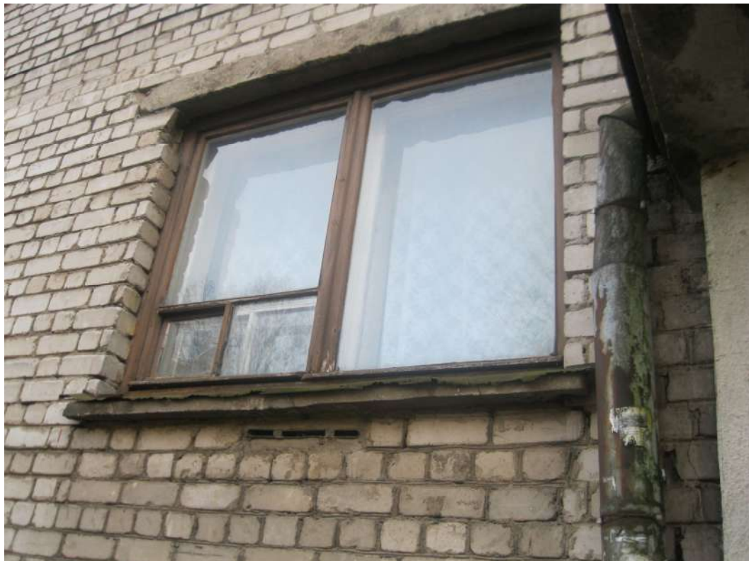
5 pav. Senų medinių langų būklė prasta - langai nesandarūs, jų rėmai papuvę, išsikreivinę, langus labai sunku, o kai kurių net neįmanoma, varstyti.
