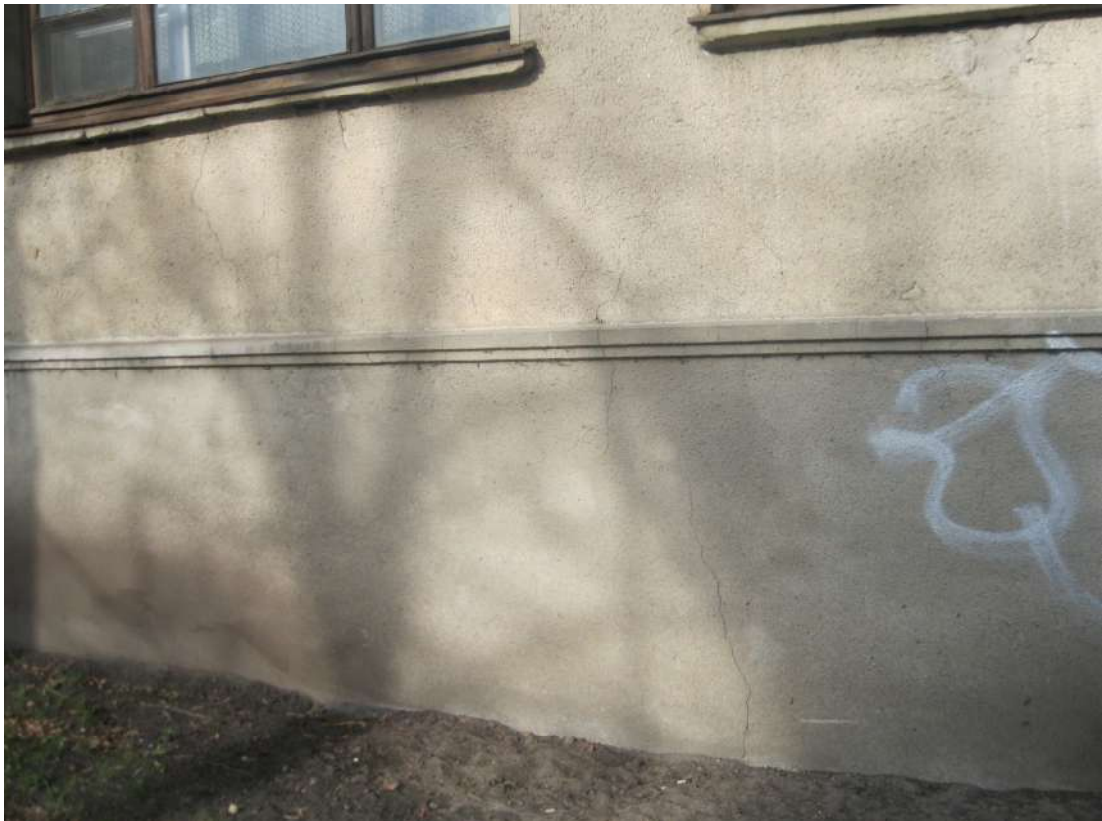
18 ir 19 pav. Pastebėti plyšiai fasadų ir cokolio tinke.
