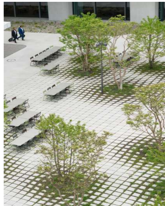
206 pav. Viršuje: vandeniui laidžios dangos pavyzdys, įgyvendintas Kaizeraugste. Projekto ir nuotraukos aut.: BRYUM. 207 pav. Dešinėje: daugiabučių viešosios erdvės, pėsčiųjų takų pavyzdys Champigny-sur-Marne miestelyje. Projekto aut. ChartierDalix. Nuotraukos aut.: ZOA.
